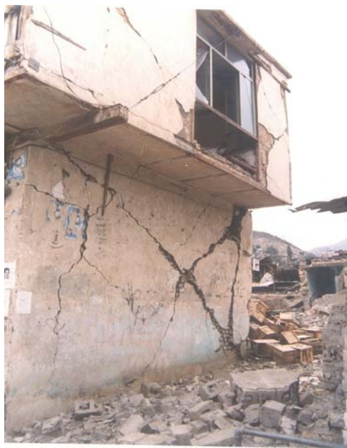
شکل ۱ : نمونه عملکرد مرکب قاب- میانقاب در زلزله رودبار منجیل
