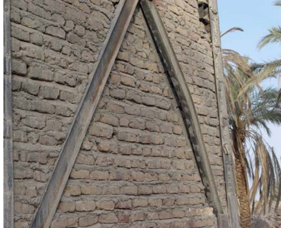
شکل ۲: نمونه عملکرد مرکب قاب-مهاربند - میانقاب در زلزله بم
