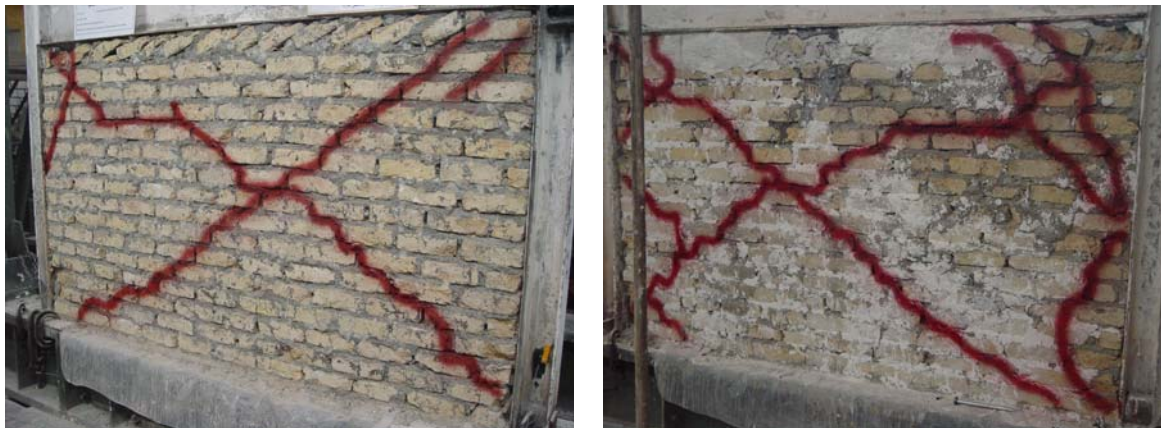
شکل ۶ نمایی از مسیر ترک ها در دو طرف دیوار
