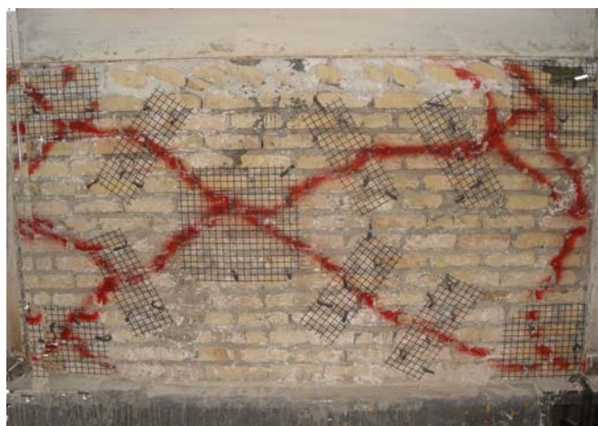
شکل ۷ نمایی از موقعیت نصب شبکه فلزی
