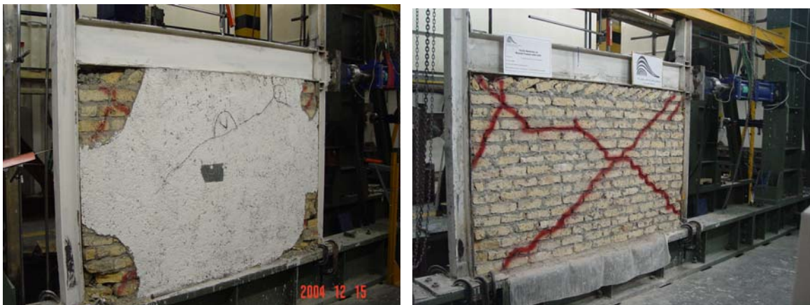
شکل ۱۴ نمایی از موقعیت ترک پشت دیوار قبل و بعد از طرح بهسازی
