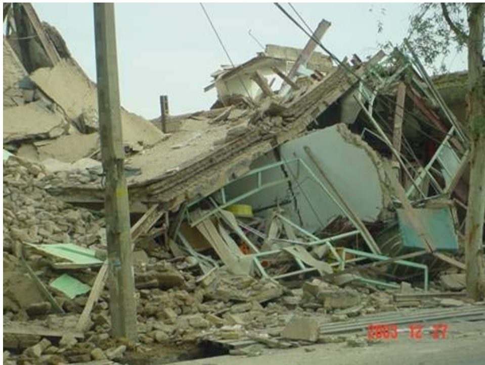
شکل-7: نمونه خرابی در بم
