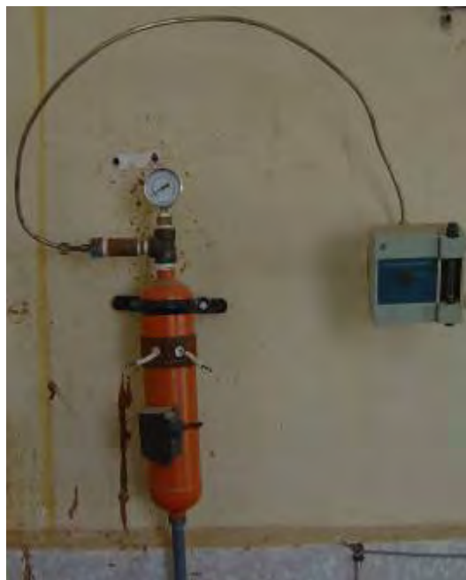
شکل (۶-۲): نمایی از سیستم کلرزی و لوله مرتبط به آن
