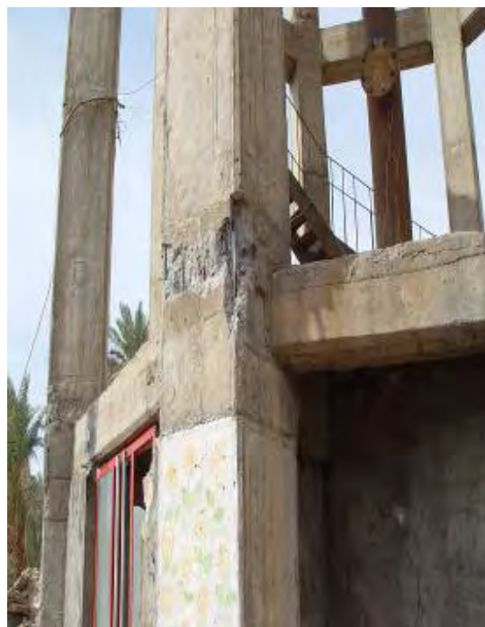
شکل (۵-۱۲): کمانش آرماتورهای طولی و خردشدن بتن در ستون
