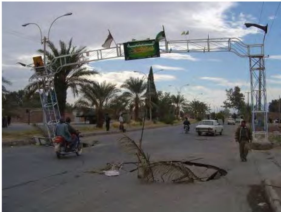
شکل (۶-۴۳): فروچاله ایجاد شده در خیابانهای براوات
