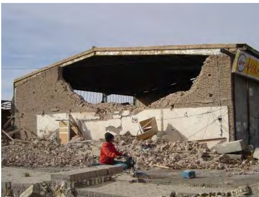
شکل (۵-۲): فروریزش پرکننده های میانقاب به علت عدم استفاده از کلافهای فولادی قائم و افقی
