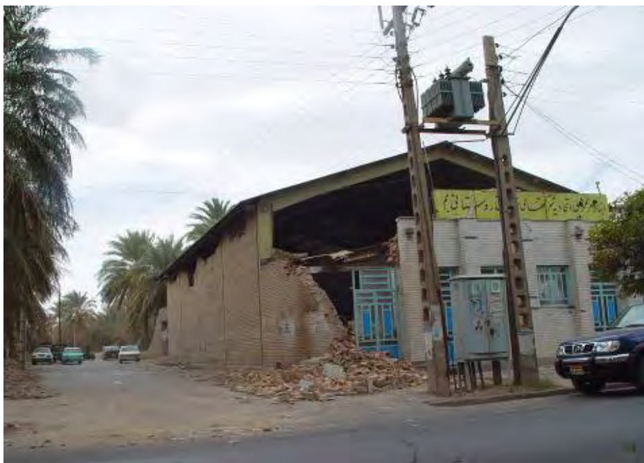
شکل (۵-۱): تخریب ساختمانهای الحاقی قابهای شیبدار
