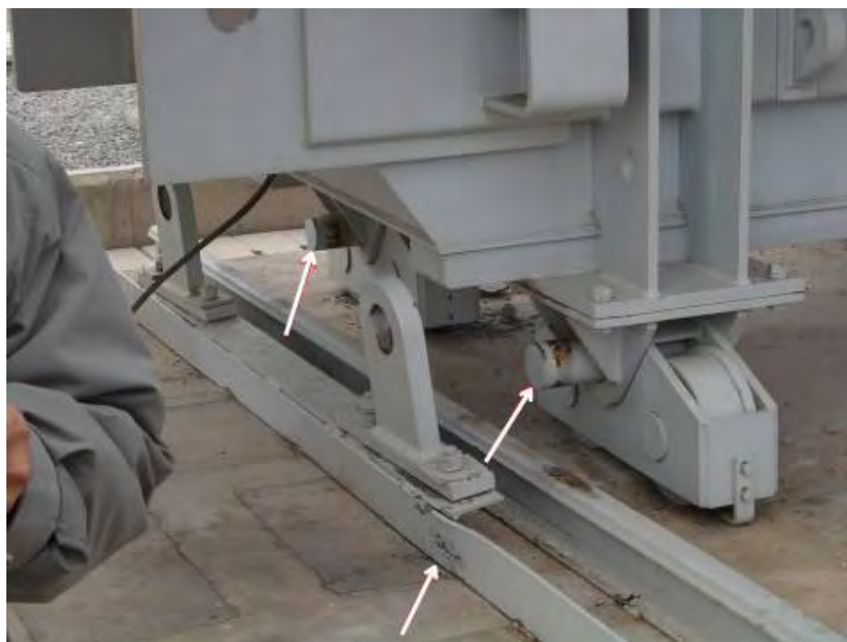
شکل (۶-۲۰): لغزش ترانسفورماتور و خروج پینها از محل خود
