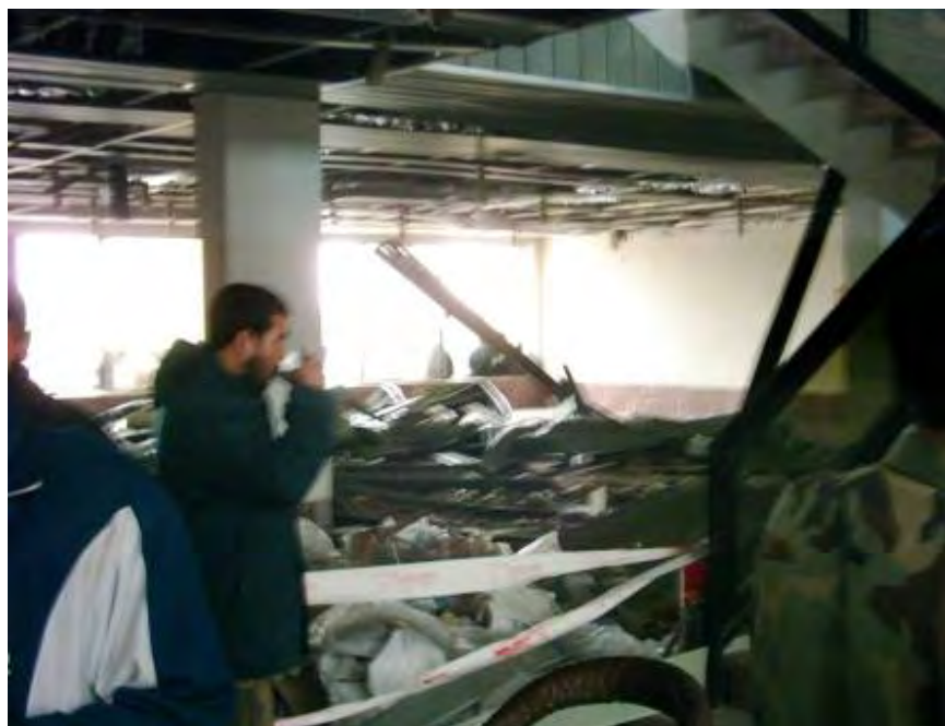
شکل (۵-۲۴): تخریب سقف های کاذب
