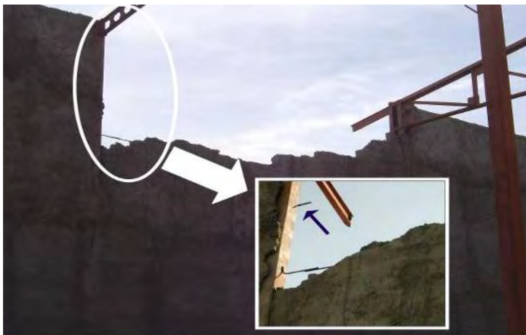
شکل (۳-۵): فروریزش میانقابها به دلیل اجرای نادرست مهار افقی
