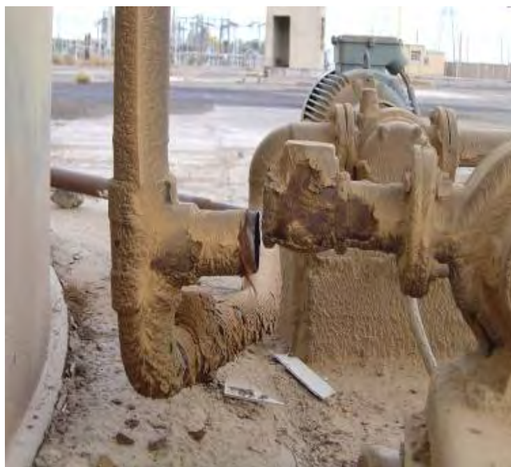
شکل (۲۱-۵): شکست اتصالات لوله های متصل به مخزن
