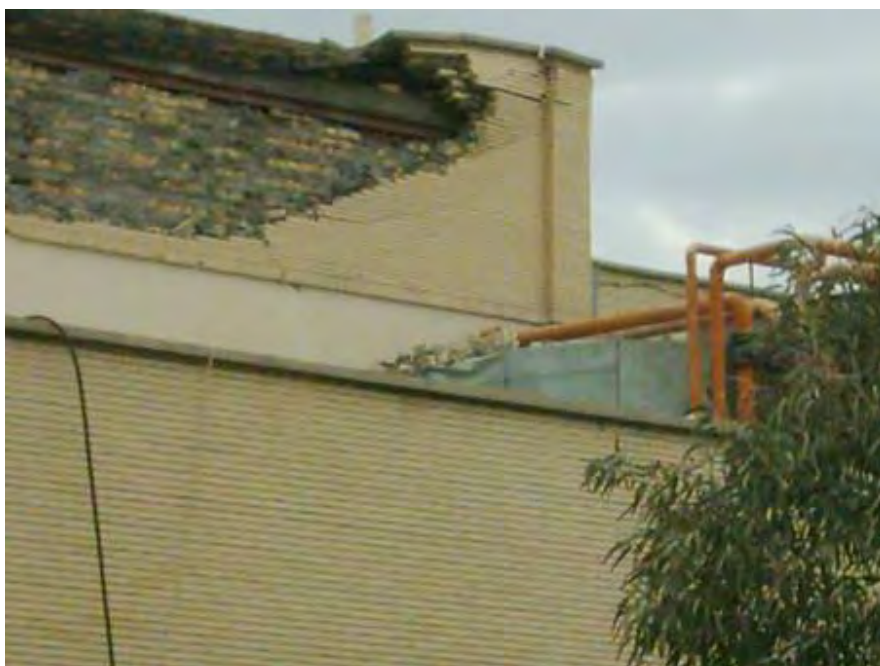
شکل (۵-۲۷): فرو ریزش نما و آسیب دیدگی تاسیسات مکانیکی
