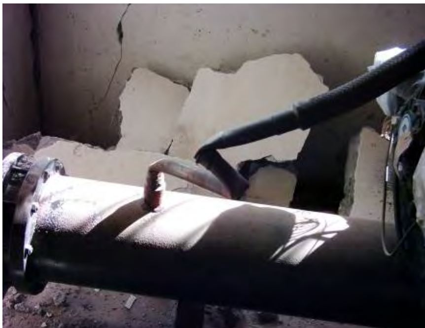
شکل (۷-۵): ایجاد تغییر شکل‌های ماندگار در تجهیزات مکانیکی
