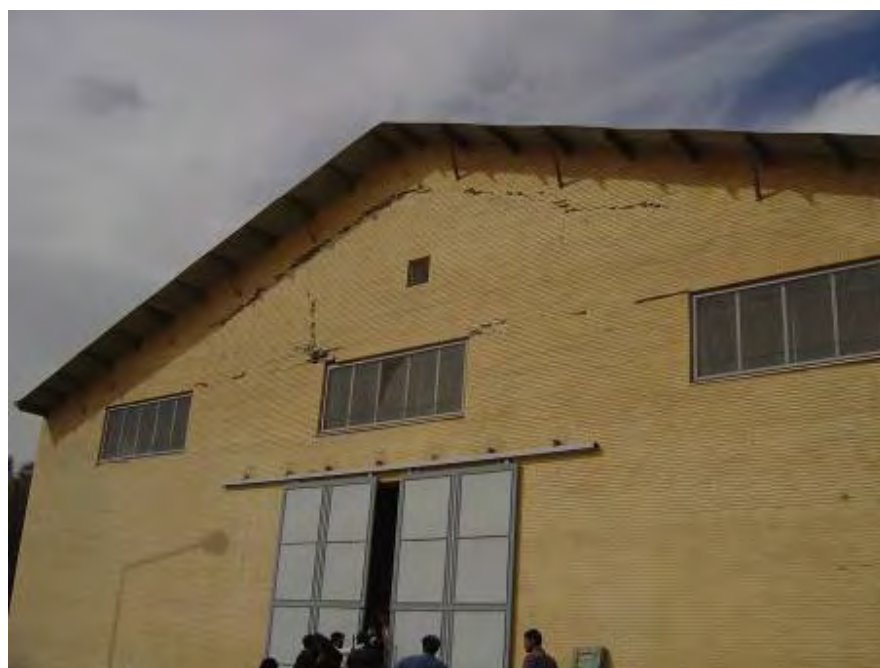
شکل (۳-۵): فروریزش میانقابها به دلیل اجرای نادرست مهار افقی
