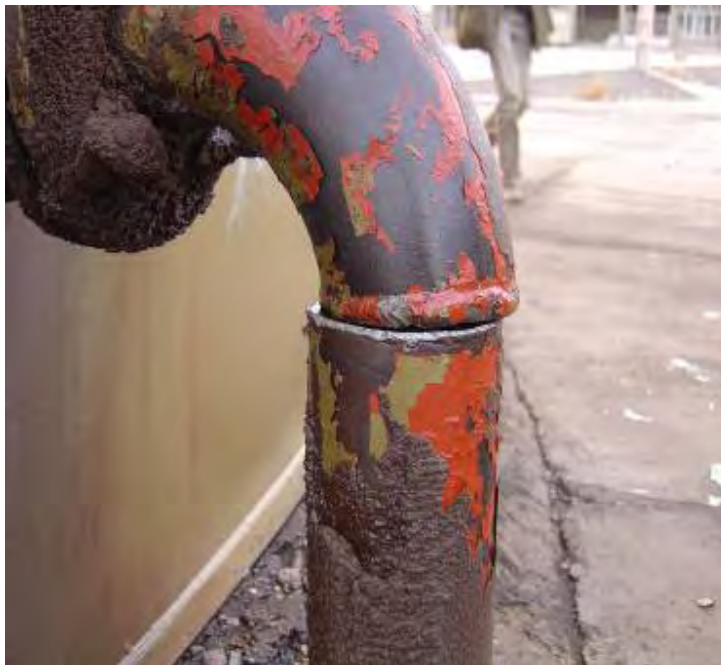
شکل (۵-۲۲): شکست اتصالات لوله های متصل به مخزن
