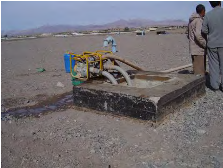
شکل (۶-۸): انتقال آب از مخزن زمینی به تانکرهای حمل آب بوسیله پمپ سیار
