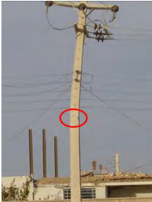
شکل (۳۱-۶): شکست ایجاد شده در تیر برق
