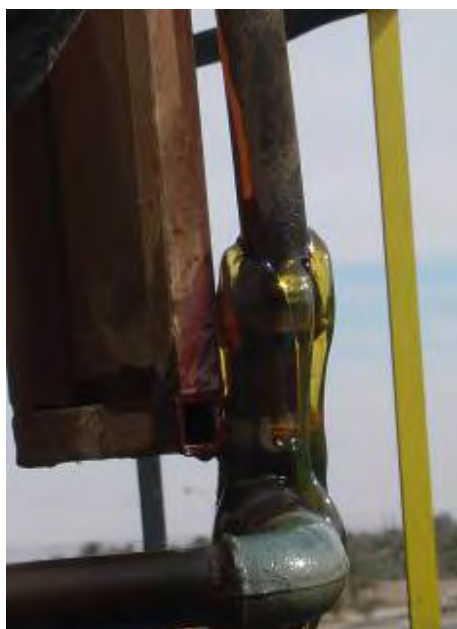
شکل (۵-۱۹): شکست اتصال لوله مخزن و نشت روغن
