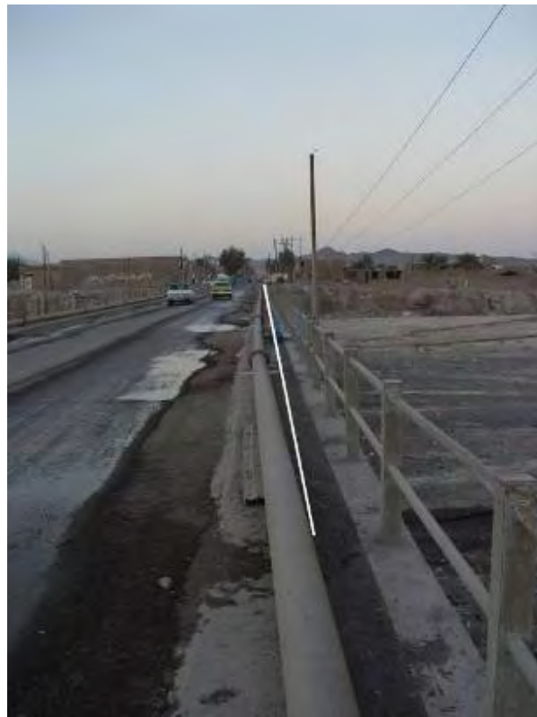
شکل (۳۱-۵): کمانش لوله انتقال آب از موضع اولیه
