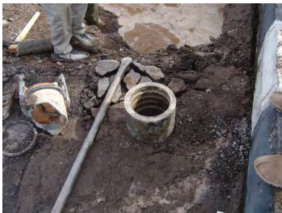
شکل (۶-۶): تعویض اتصالات قدیمی و جدید
