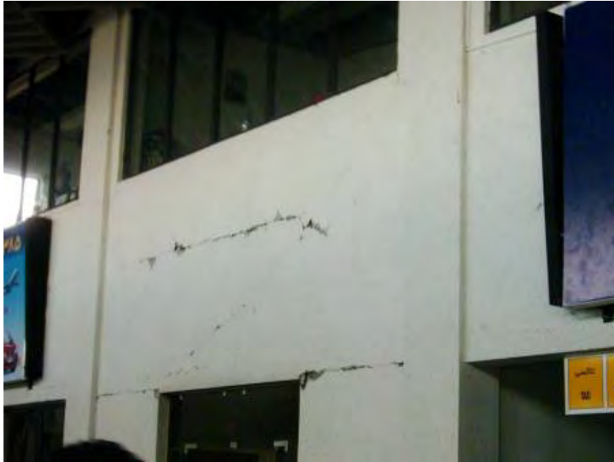
شکل (۵-۲۸): ترک خوردگی میانقابها
