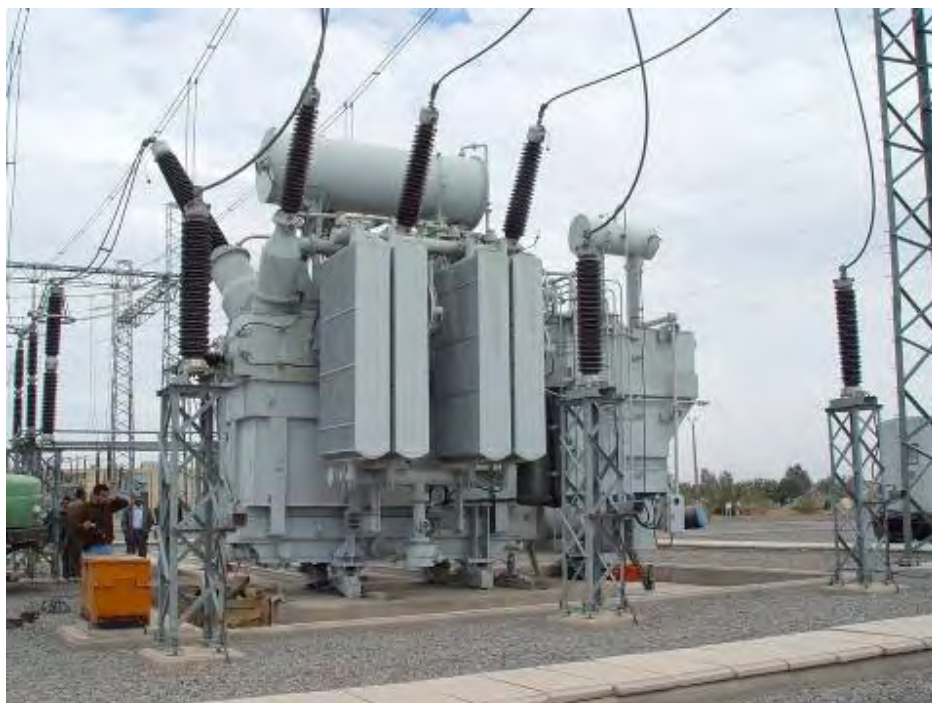
شکل (۶-۱۹): نمای ترانسفورماتور 230 kv
