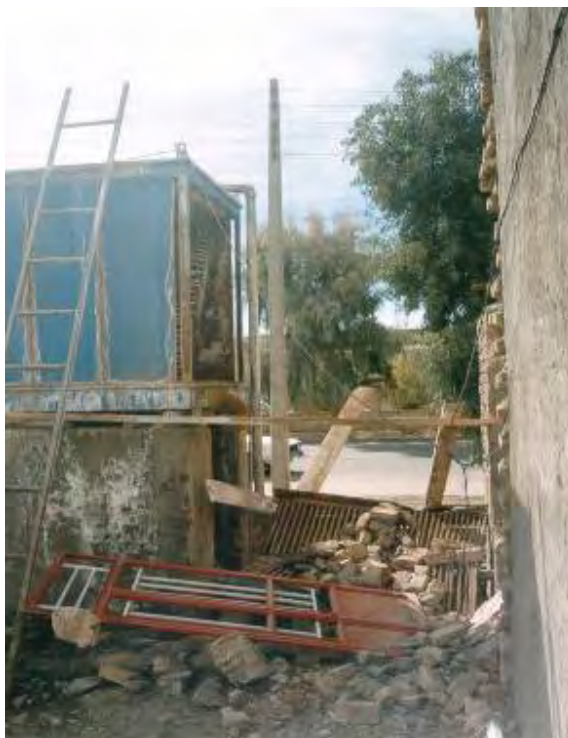
شکل (۸-۵): سقوط بخش‌هایی از تاسیسات مکانیکی
