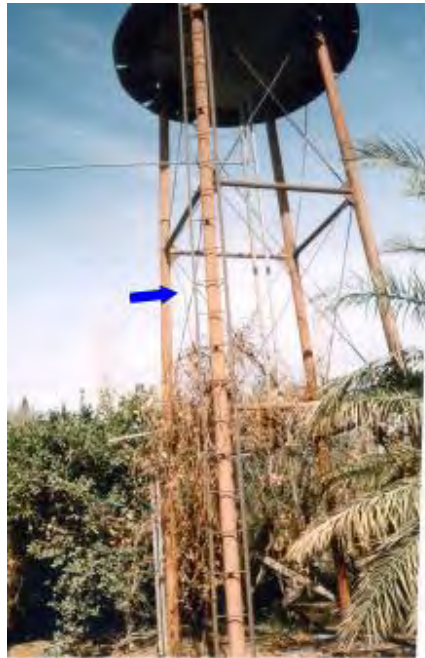
شکل (۵-۱۳): کمانش مهاربند در مخزن هوایی فولادی
