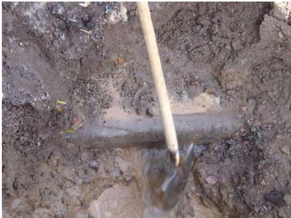
شکل (۵-۶): نشت آب از محل شکست
