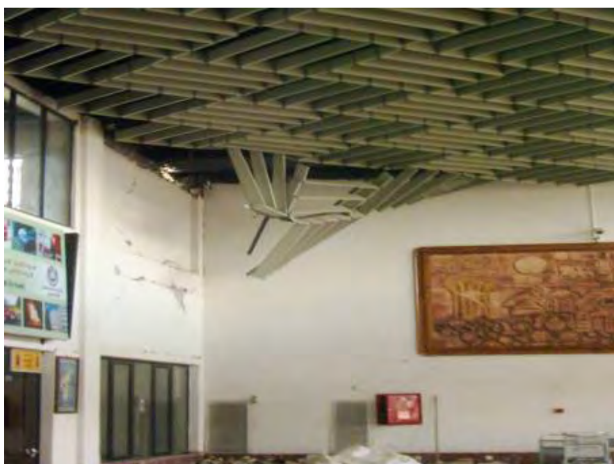
شکل (۵-۲۵): ریزش سقفهای کاذب
