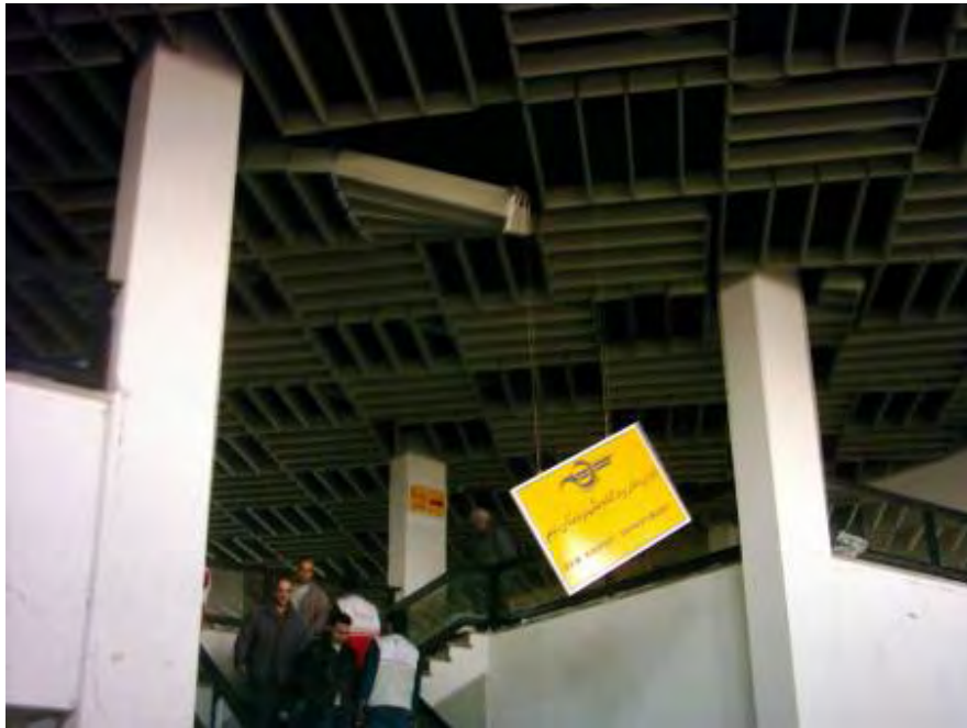
شکل (۵-۲۶): فرو ریزش تابلوهای راهنما
