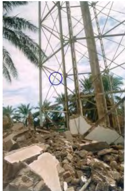
شکل (۵-۱۴): ایجاد شکست در محل اتصال میان دهانه مهاربند
