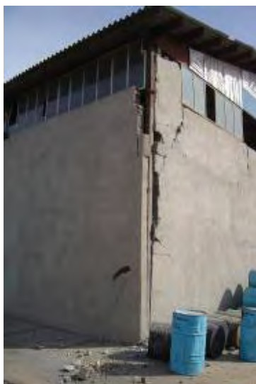
شکل (۲۰-۵): عدم مهار کافی میانقاب به ستون
