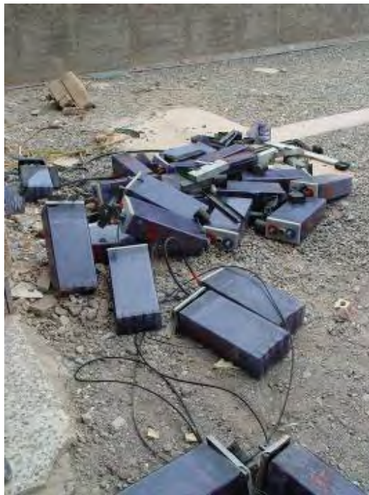
شکل (۶-۳۸): باتریهای واژگون شده در مرکز مخابرات براوات
