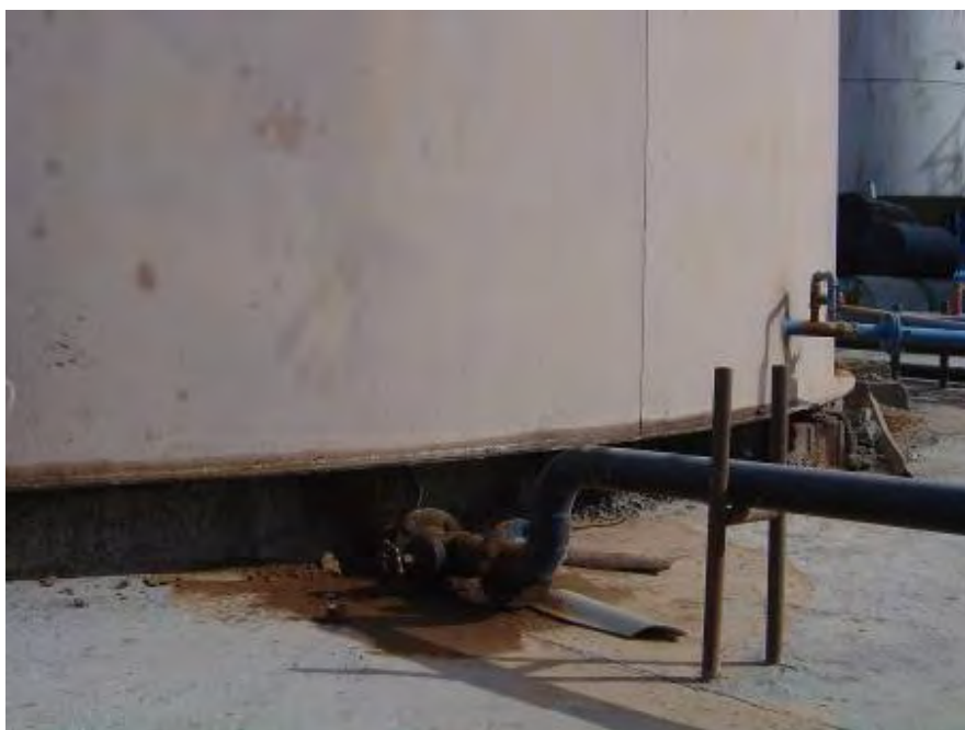
شکل (۵-۱۷): فرار گیری نادرست مخزن روی بستر
