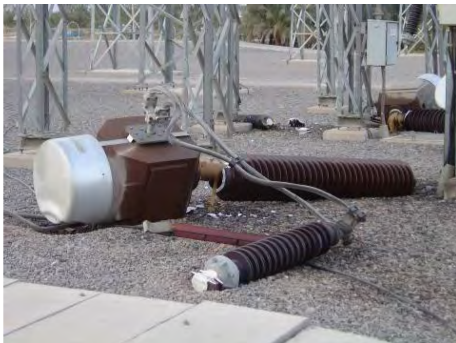
شکل (۶-۱۵): فروافتادن مقره های از جنس چینی ترد شکن
