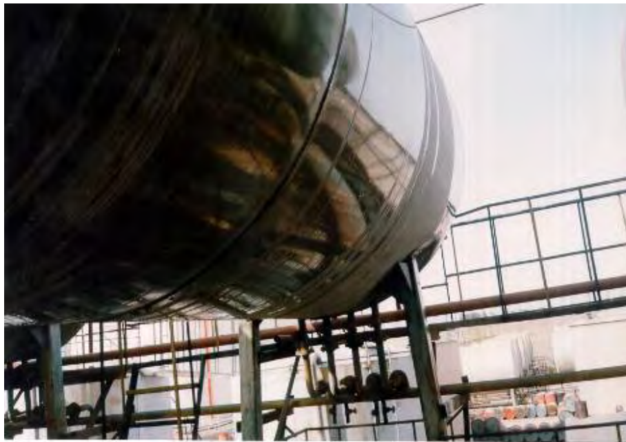
شکل (۵-۱۸): قرشدگی در پوسته در محل اتصال ستون
