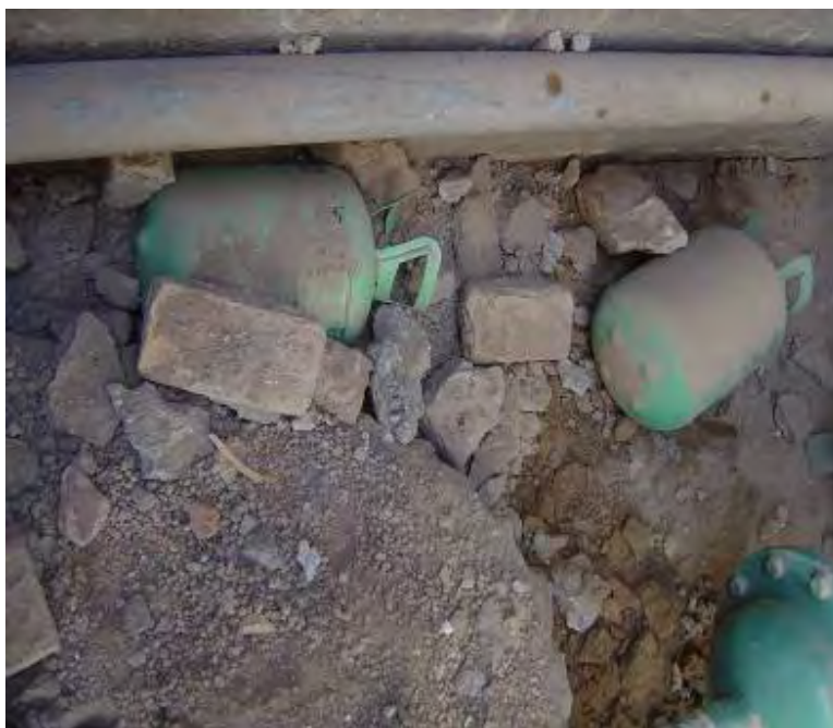
شکل (۵-۹): سقوط محفظه های حاوی مواد شیمیایی
