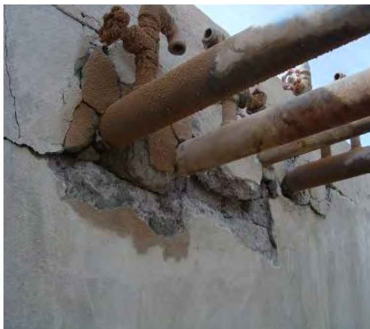
شکل (۵-۱۰): آسیب دیوار آجری در محل عبور لوله ها
