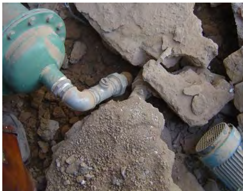
شکل (۵-۶): شکست لوله ها در اثر ریزش آوار
