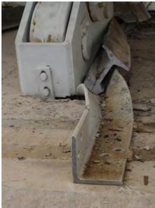
شکل (۶-۲۵): اعوجاج نبشی زیر سری و شکست ریل
