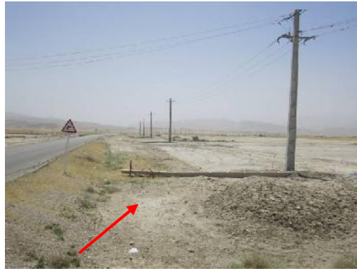
شکل ۴: وضعیت پایه بتنی ۴۰۰-۱۲ تخریب شده بر اثر زلزله بعد از نصب پایه های جدید
