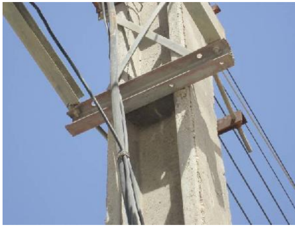
شکل ۸: تغییر شکل بال ناودانی کوتاه ناشی از گسیختگی ناودانی بلند
