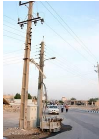
شکل ۷: ترانسفورماتور واژگون شده در اثر زلزله بوشهر
