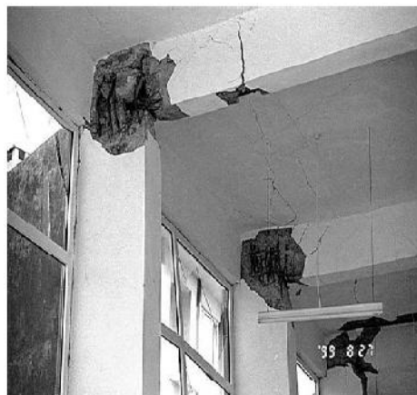
شکل ۱: آسیب در اتصال تیر به ستون در زلزله ترکیه (Sezen et al., 2003)
