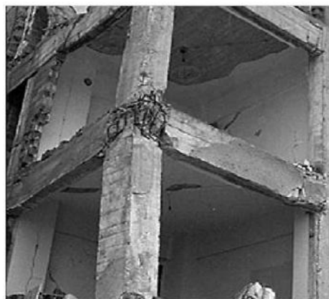
شکل ۱: آسیب در اتصال تیر به ستون در زلزله ترکیه (Sezen et al., 2003)
