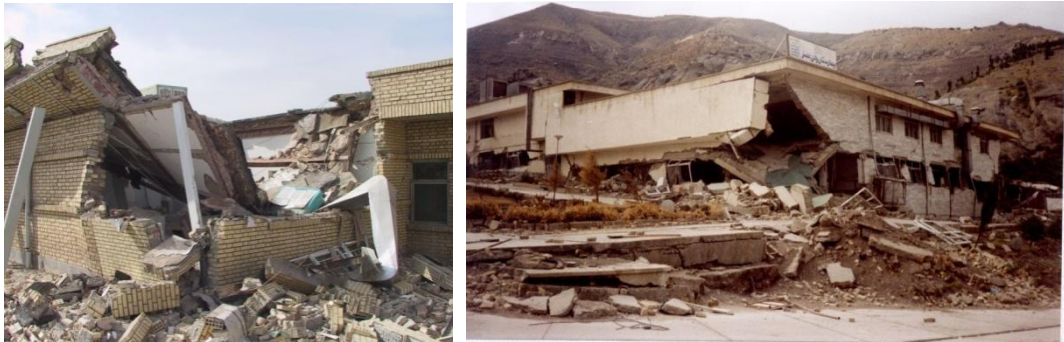
شکل ۱: آسیب بیمارستان ولی عصر (عج) در زلزله منجیل (۱۳۶۹) و بیمارستان امام خمینی (ره) در زلزله بم (۱۳۸۲)
