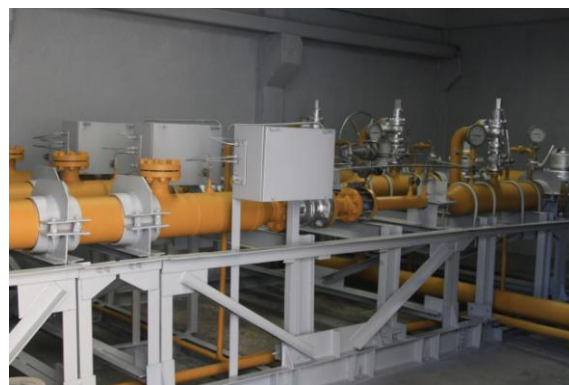
شکل ۳: (راست) نمایی از ایستگاههای تقلیل فشار گاز، (چپ) جعبه کنترل سامانه قطع جریان گاز
