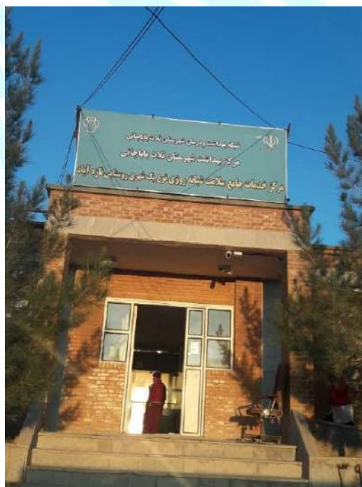
شکل ۱۲-۸۶- نمای غربی مرکز
