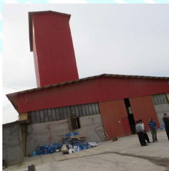
شکل ۱۱-۱۸- عدم آسیب به سوله و برجک آن پس از زلزله - کارخانه دان پارت شهرک صنعتی سرپل‌ذهاب
