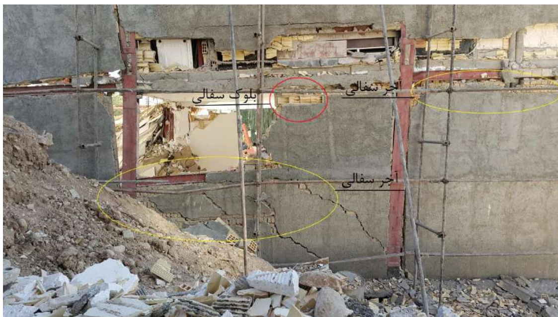
شکل ۹-۱۵- استفاده از آجر سفالی به همراه بلوک سفالی در طبقه همکف در ساختمان شاهد
