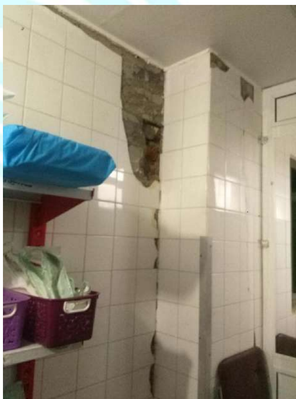
شکل ۱۲-۷۵- ترک‌خوردگی دیوارها
