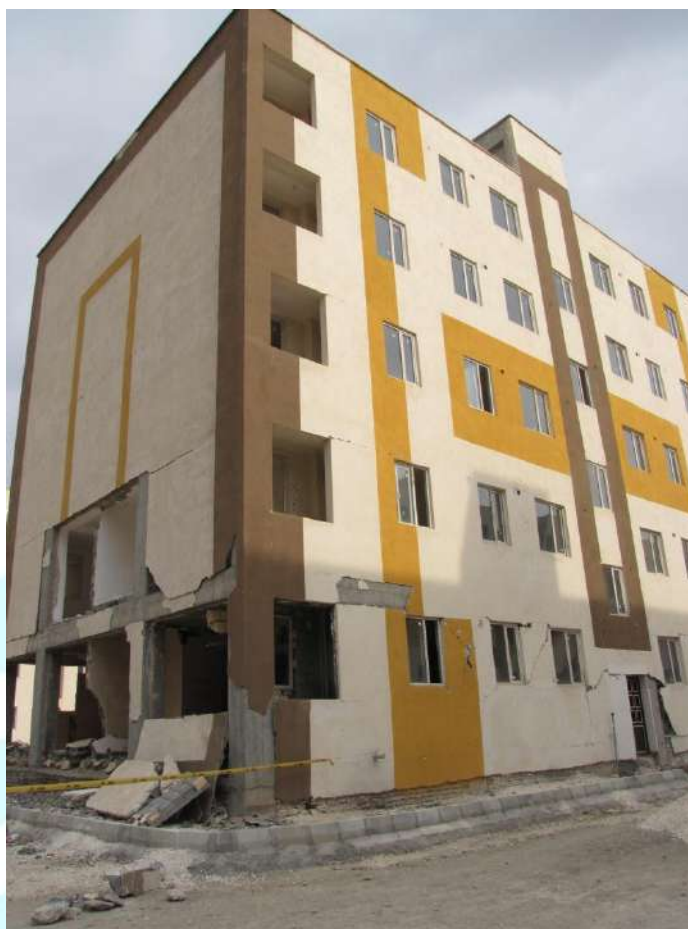
شکل ۸-۴۶- تیپ ساختمان‌های قاب خمشی در دو جهت
