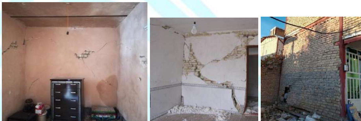
شکل ۷-۱- ترک‌خوردگی دیوار در ساختمان‌های آجری کلاف‌دار
