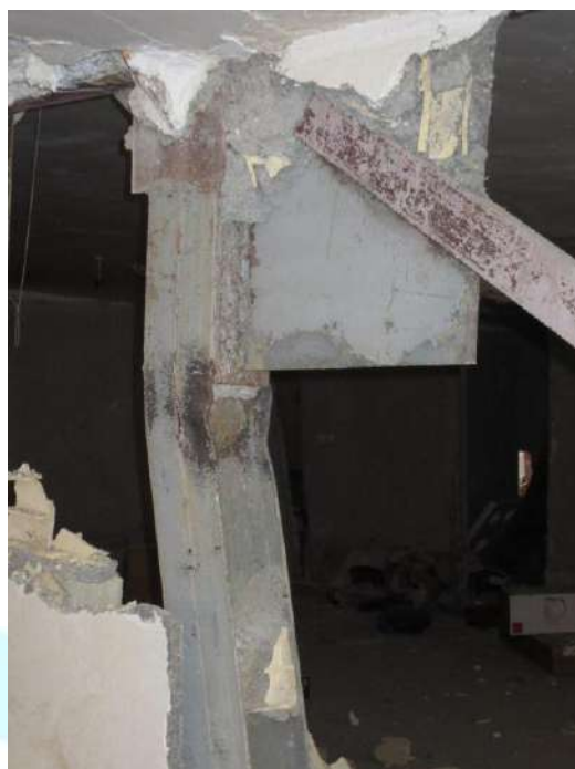
شکل ۸-۲۷- انتقال باربری بعد از کار افتادن سیستم مهاربندی در یک دهانه و خمش و خسارت خیلی زیاد در ستون
