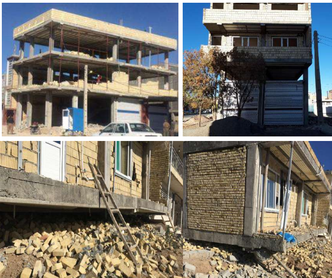
شکل ۵-۷- نمای از مودهای شکست پیچشی
