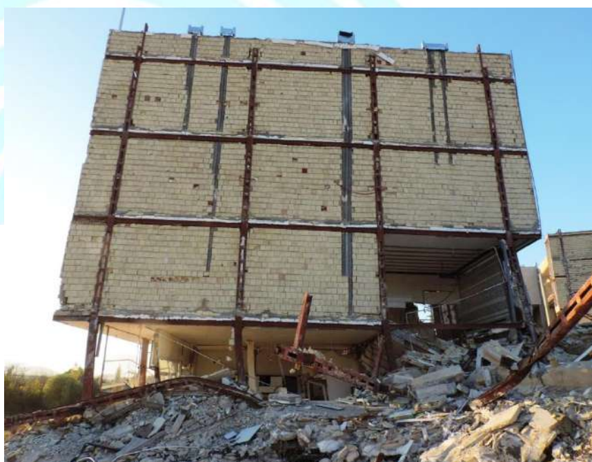
شکل ۹-۱۸- نرم شدن طبقه همکف طبقه همکف و کاهش تفاضات بالاتر در ساختمان شاهد
