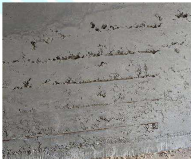
شکل ۸-۷۴- اجرای نامناسب دیوارهای برشی
