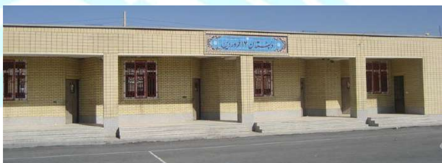
شکل ۱۳-۲۳- تصویر ساختمان بهسازی لرزه‌ای شده پس از زلزله
