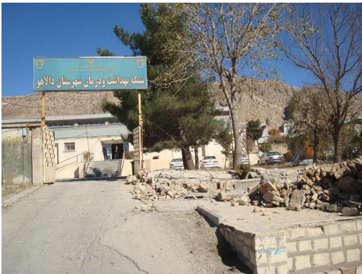
شکل ۱۴-۳- نمونه‌ای از خرابی دیوارهای پیرامونی ساختمان
