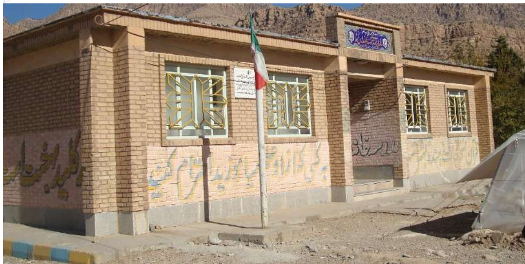
شکل ۱۳-۷- مدرسه دارای کلاف افقی و قائم که رفتار مناسبی در زلزله داشت.
