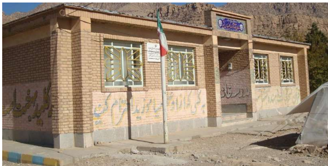
شکل ۱۴-۴ دیوارهای مدرسه کلاف‌بندی شده روستای پاتاق
