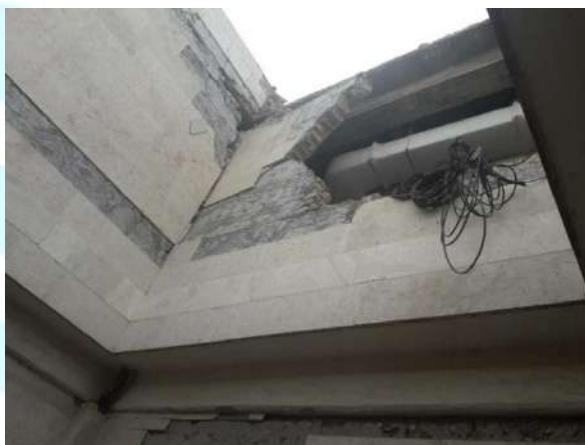
شکل ۱۲-۱۵- ریزش دیوار
