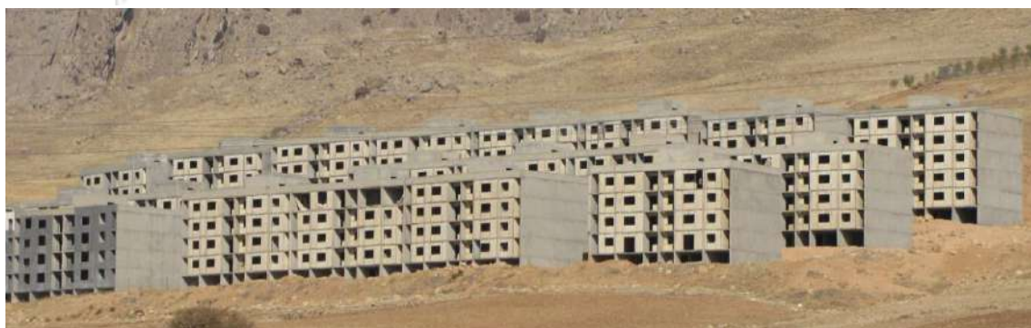
شکل ۸-۶۹- نمای جنوبی بلوک‌های مسکن مهر دالاهو (کرند غرب)
