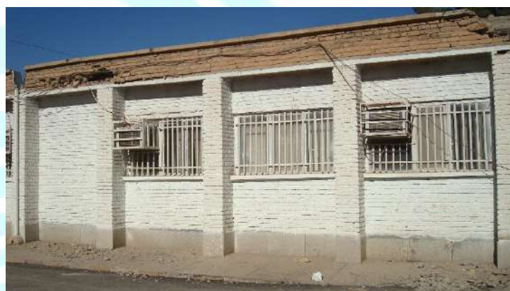
شکل ۱۳-۱۰- آسیب‌ها وارد به سازه‌های فاقد المان لرزه بر در مجتمع آموزشی نشان داده شده در شکل ۱۳-۹
