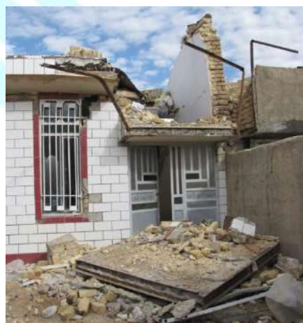
شکل ۷-۷- تخریب کلی یا موضعی خرپشته
