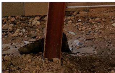
شکل ۶-۲۳- تشکیل مفاصل پلاستیک در دو سر ستون‌ها
