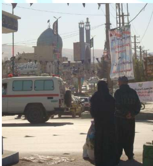
شکل ۱۴-۵ خرابی یکی از مناره‌ها
