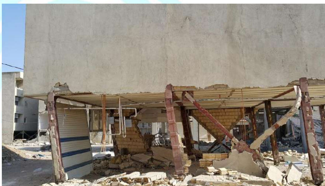
شکل ۹-۶- گسیختگی زود هنگام ورق گاست.
