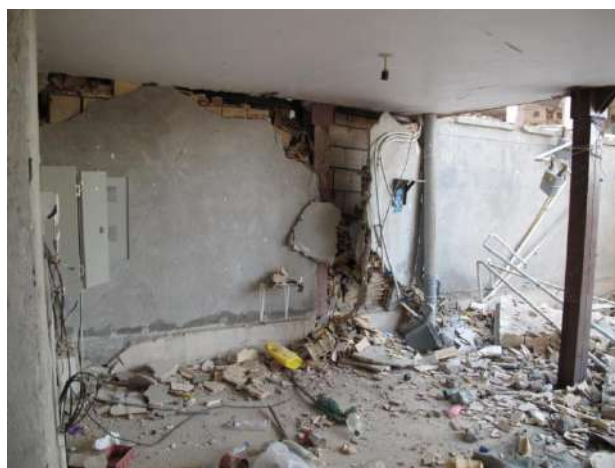
شکل ۸-۳۳- ایجاد ترک و خوردشدگی میانقاب‌ها
