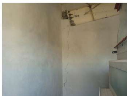
شکل ۱۳-۱۱- برخی خسارات وارد به سازه سوله روی استخر
