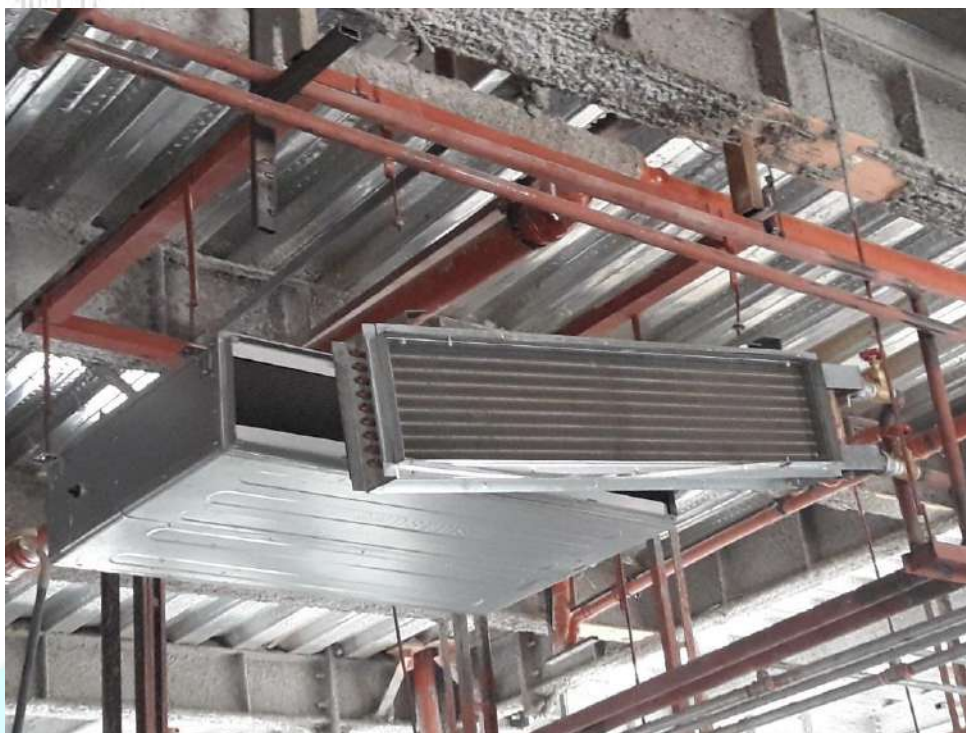
شکل ۱۲-۲۳- کنده شدن سیستم حرارتی و تاسیساتی
