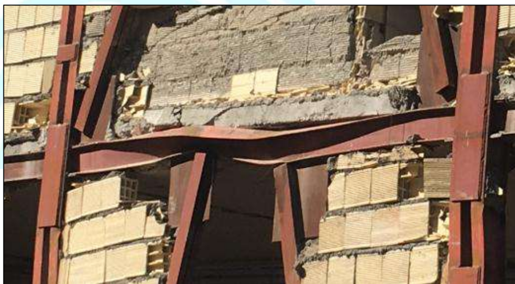
شکل ۶-۱۸- کمانش پیچشی تیر پیوند و لهیدگی جان تیر در محل اتصال مهاربند
