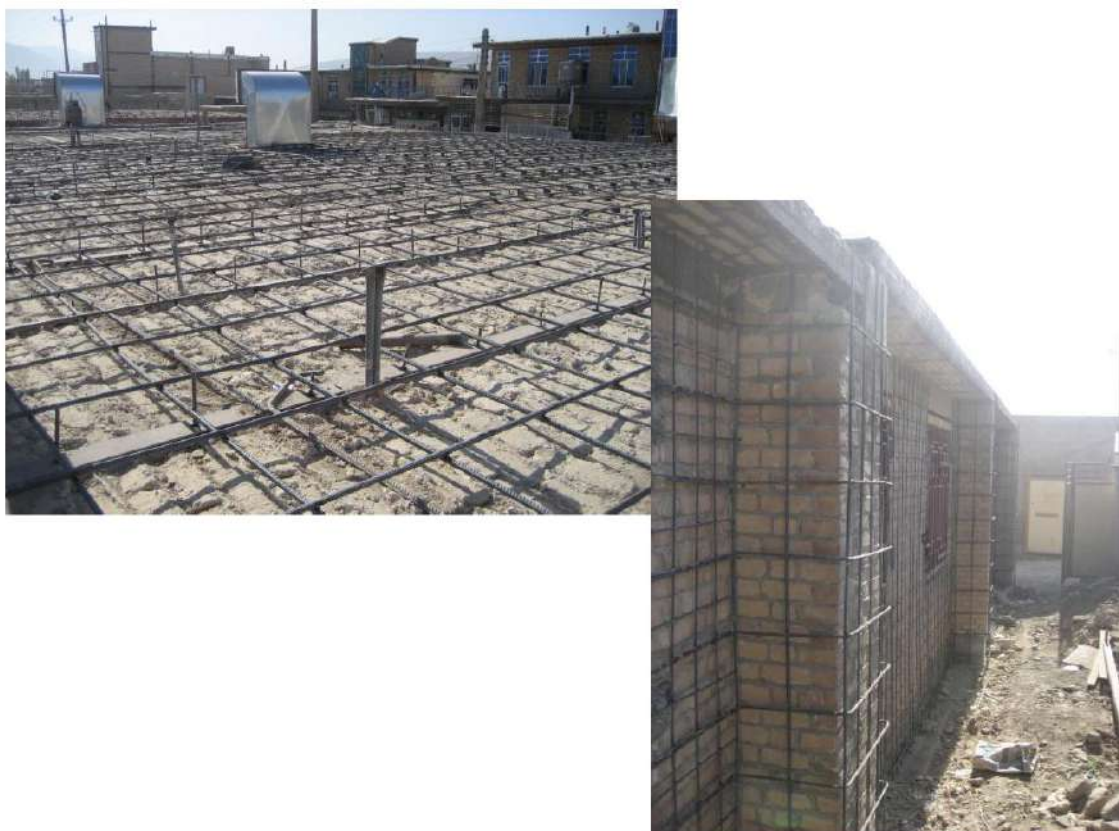
شکل ۱۳-۲۲- نحوه اجرای طرح بهسازی در دیوار (عکس راست) و سقف (عکس چپ) مدرسه ۱۲ فروردین پاوانار
