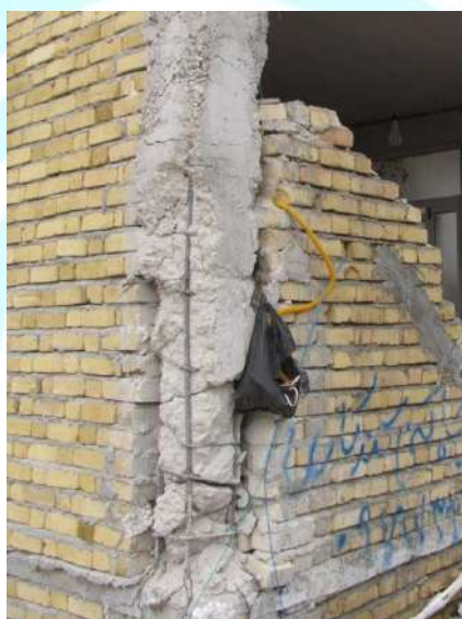
شکل ۷-۱۸- عدم هم‌زمانی اجرای کلاف قائم با دیوار آجری و فاقد اتصال و یکپارچگی کلاف قائم - دیوار
