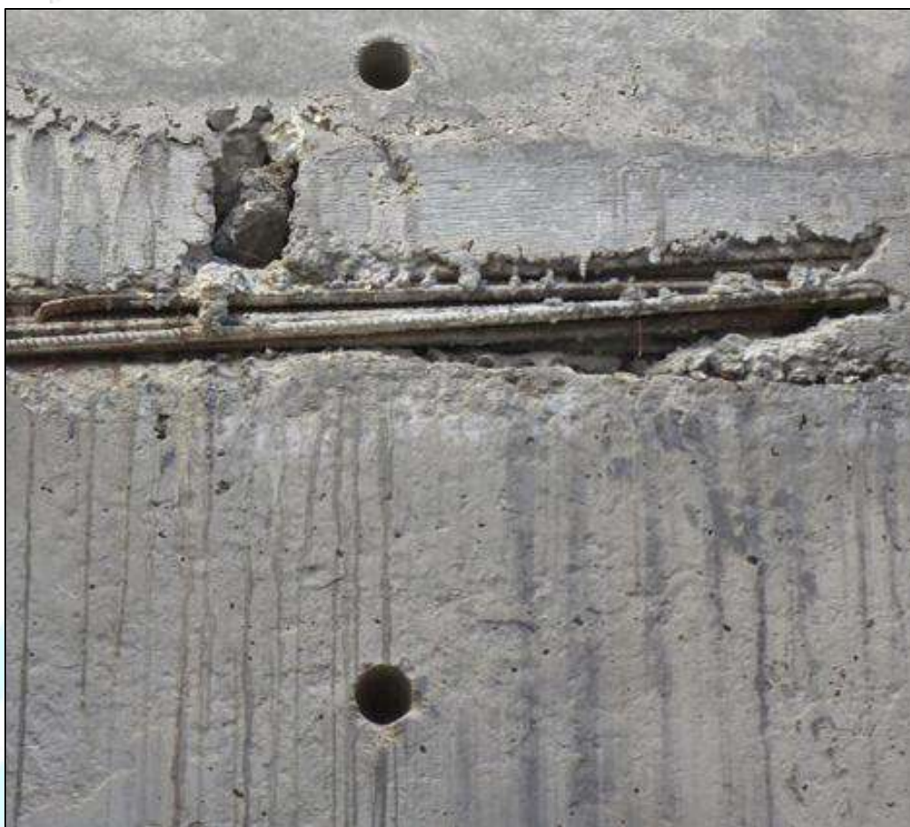
شکل ۸-۷۳- تراکم آرماتور و عدم وجود بتن در بین آنها
