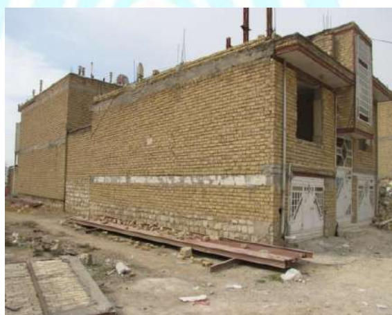
شکل ۷-۸- عملکرد ساختمان‌های مصالح بنایی با رعایت حداقل ضوابط در سرپل‌نهاب
