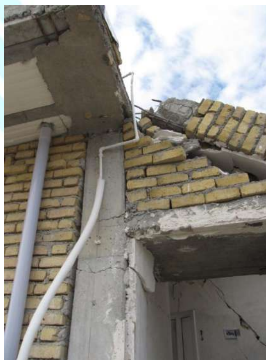
شکل ۷-۱۸- عدم هم‌زمانی اجرای کلاف قائم با دیوار آجری و فاقد اتصال و یکپارچگی کلاف قائم - دیوار
