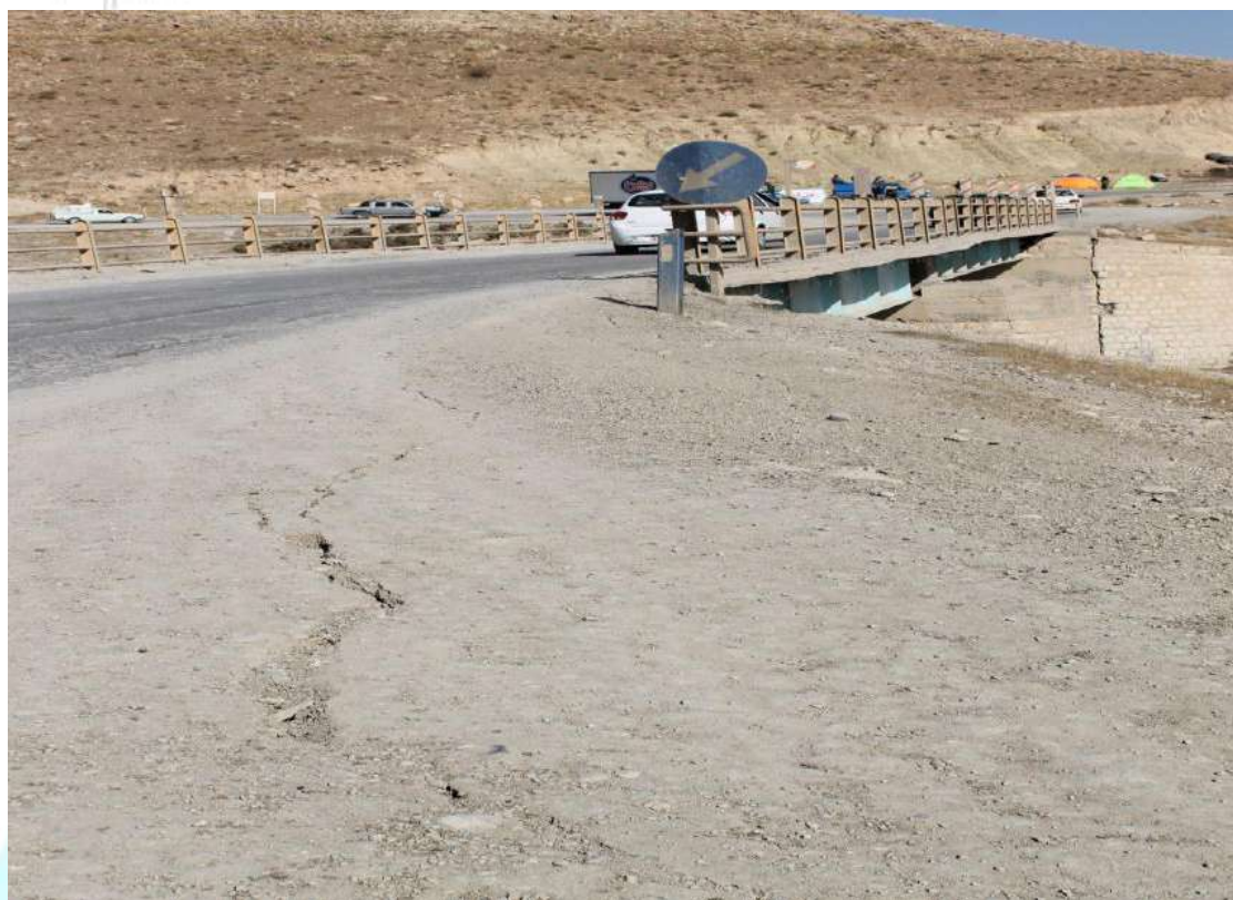
شکل ۱۰-۳- پل فلزی دو دهانه که در اطراف پل رانش‌های کوچکی مشاهده می‌شود.
