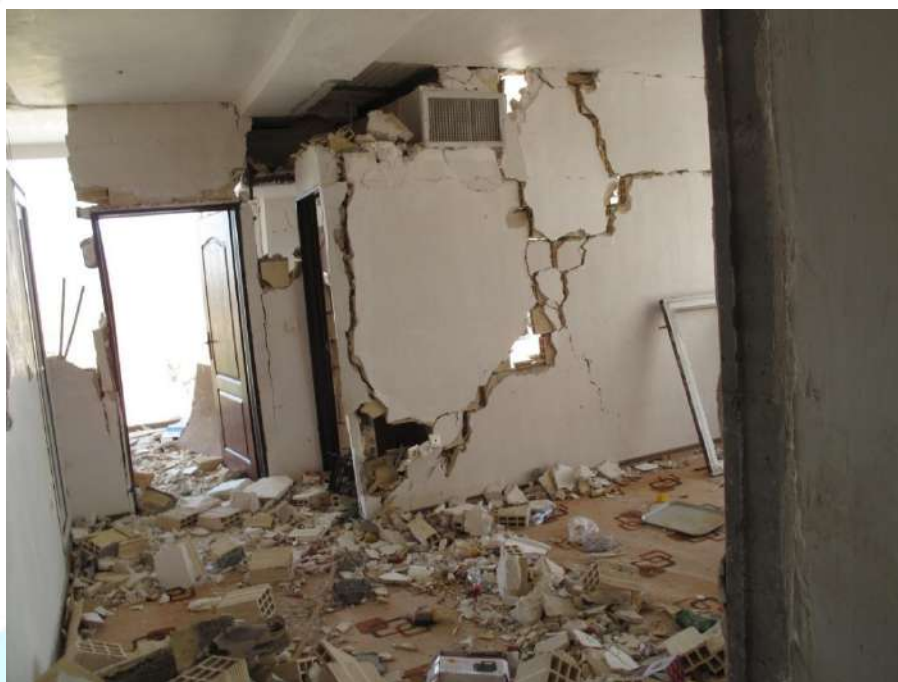
شکل ۸-۱۶- شکست پرخطر دیوار جداکننده
