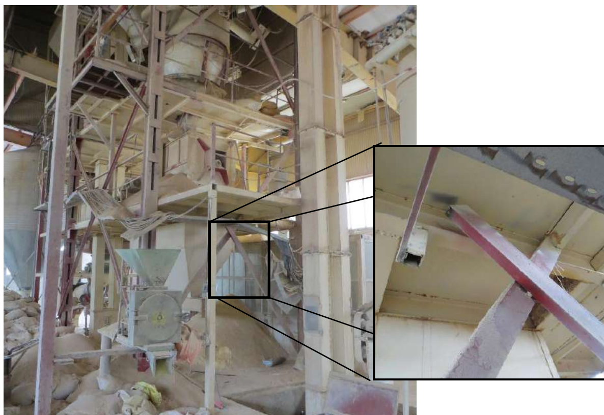
شکل ۱۱-۱۹ قطع مهاربند با هوا برش در طبقه اول برجک برای ایجاد دسترسی به طبقه
