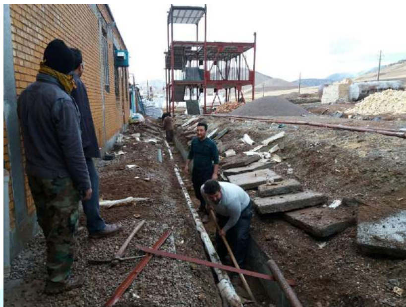
شکل ۱۲-۹۰- ترمیم سیستم لوله‌کشی آب به صورت موقت
