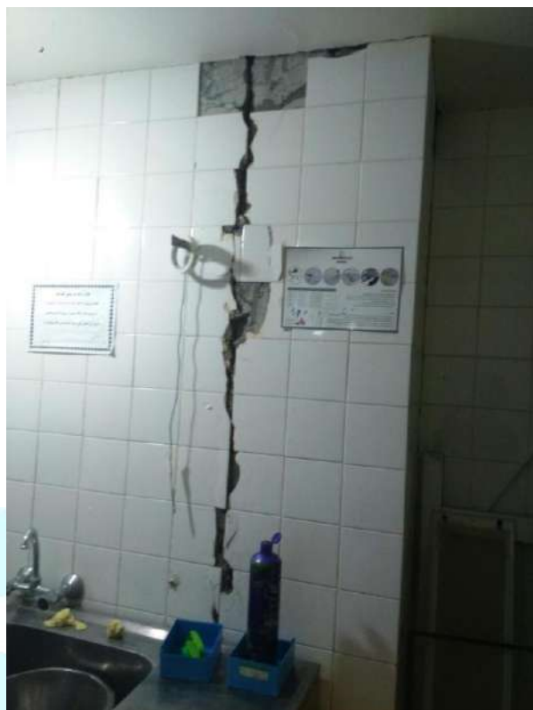
شکل ۱۲-۷۶- ترک‌خوردگی دیوارها
