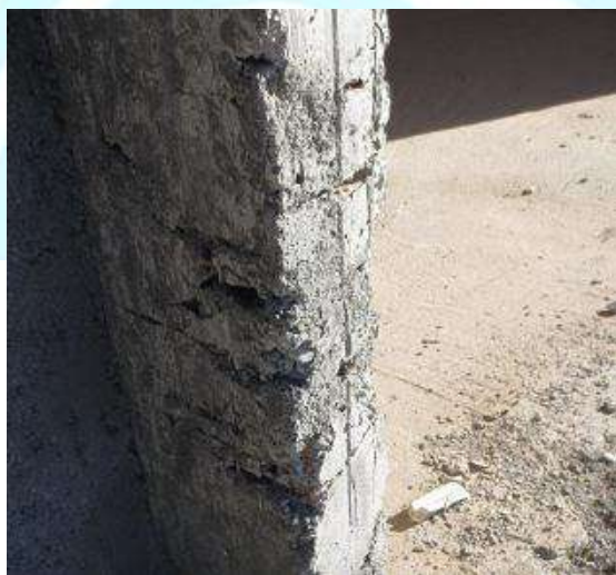
شکل ۸-۷۴- اجرای نامناسب دیوارهای برشی
