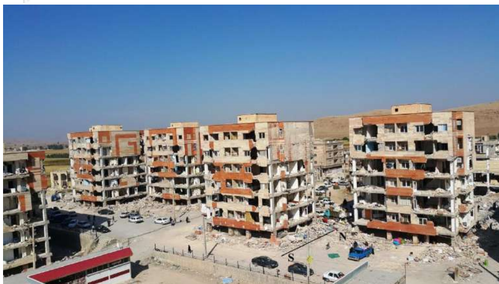
شکل ۸-۱۰- فروریزش نما و دیوارهای خارجی در راستای شمالی-جنوبی
