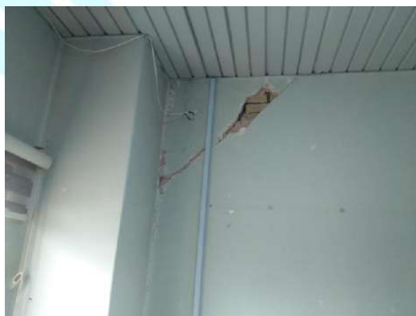
شکل ۱۲-۷۷- ترک‌خوردگی در دیوارها
