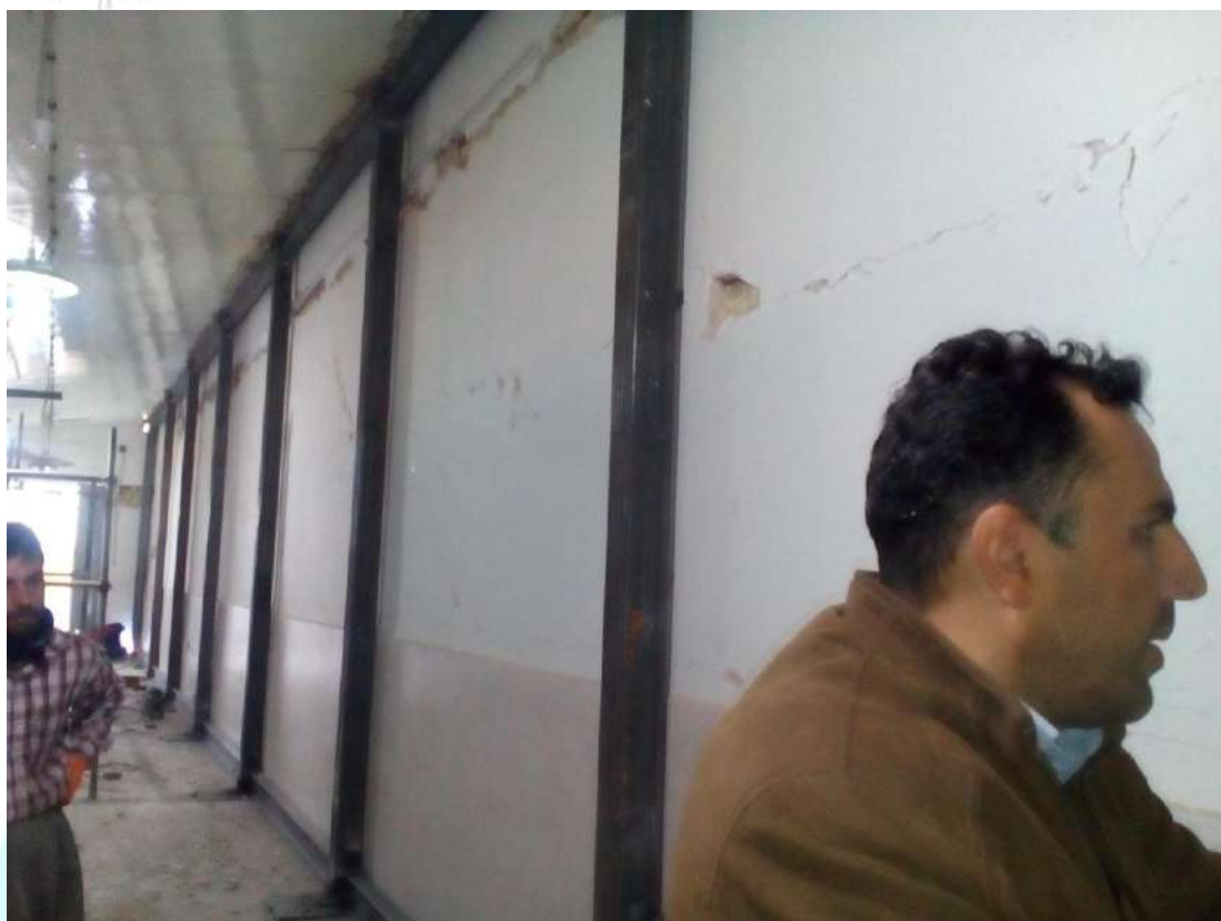
شکل ۱۰-۲۵- مقاومت سازی اضطراری اتاق کنترل در پست ۶۳kV سرپل ذهاب
