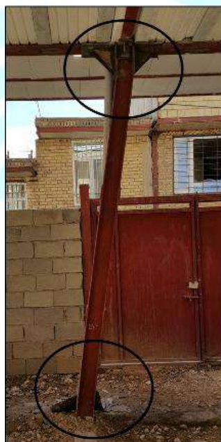
شکل ۶-۲۳- تشکیل مفاصل پلاستیک در دو سر ستون‌ها
