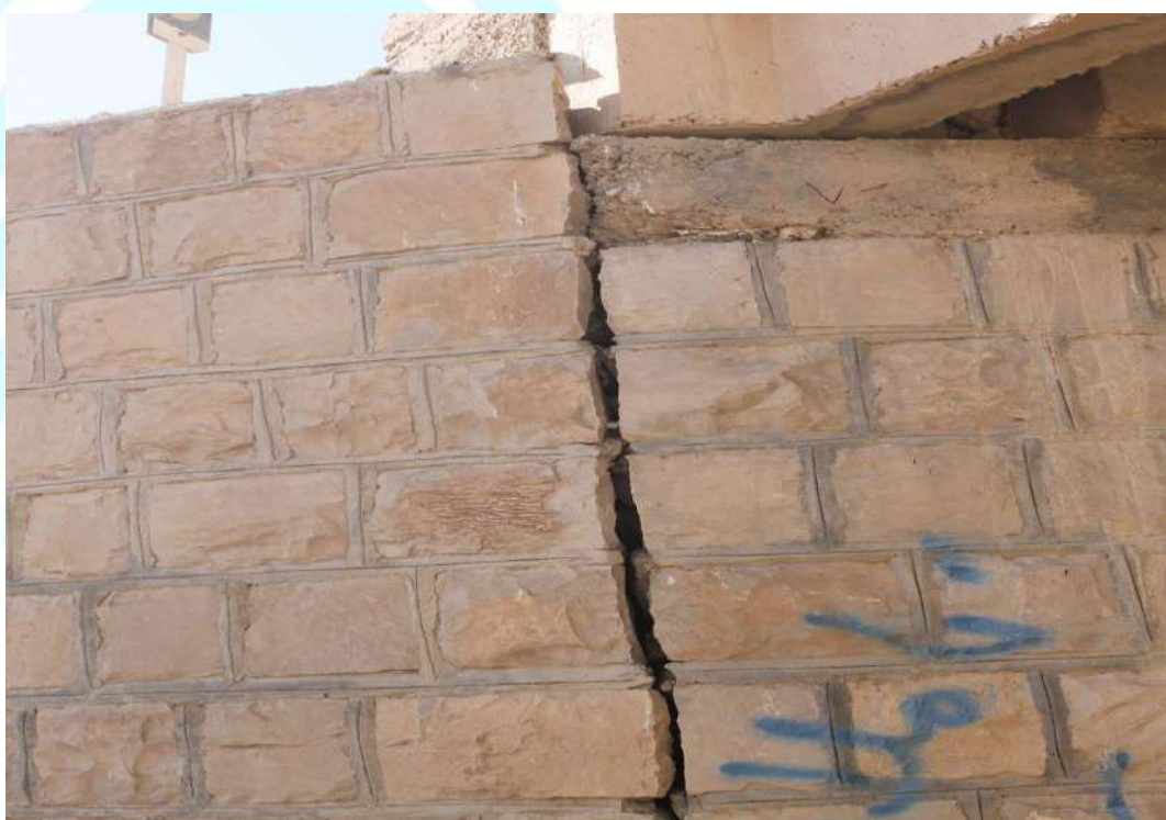
شکل ۱۰-۸- افزایش اندازه درز انقطاع در پل بتنی یک دهانه
