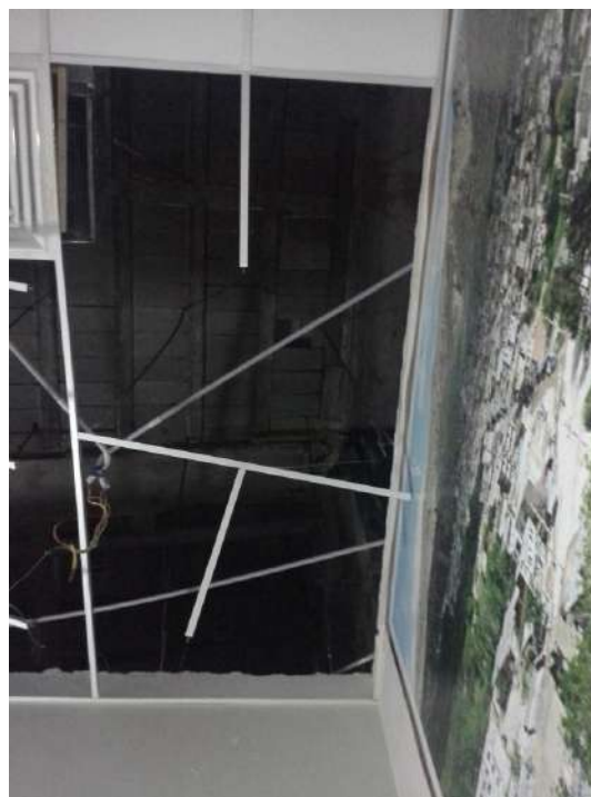
شکل ۱۲-۴۶- سقوط سقف‌های کاغذ مانند اغلب مراکز درمانی دیگر
