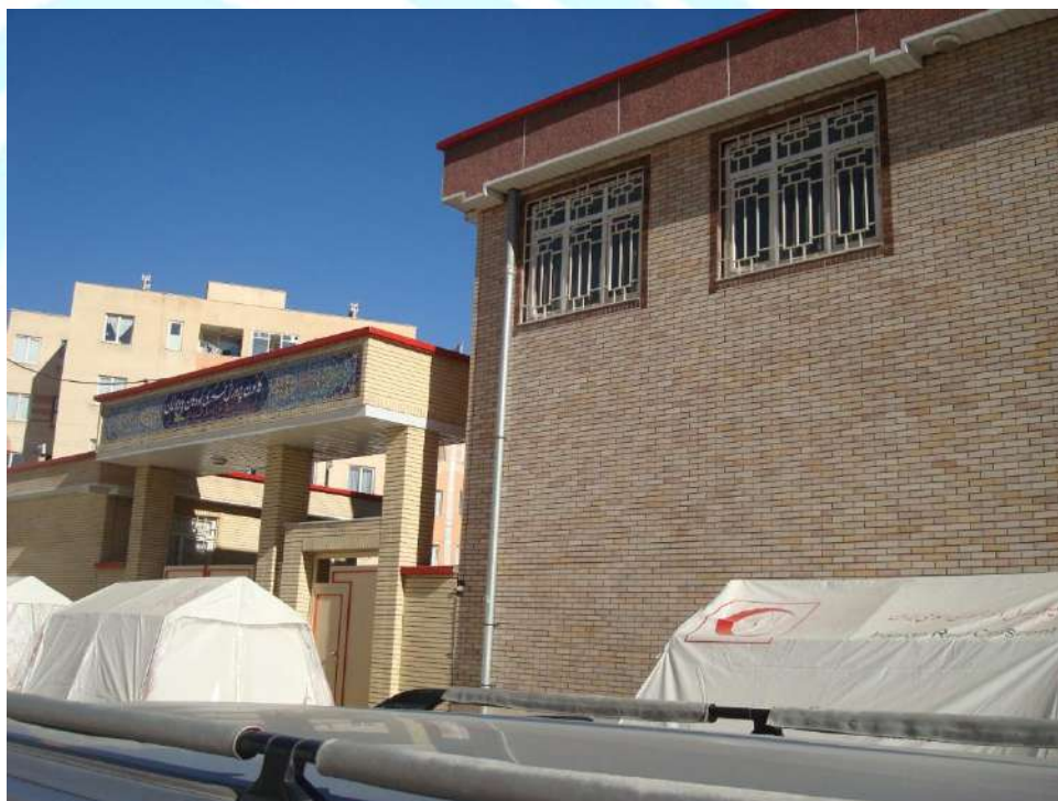
شکل ۱۳-۴- ساختمان کانون پرورش فکری که در زلزله عملکرد خوبی داشته است
