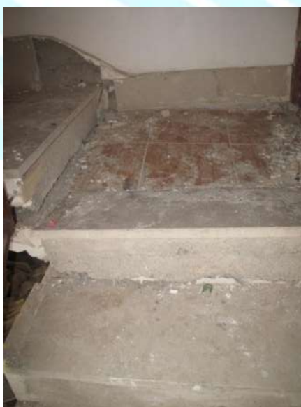
شکل ۸-۳۲- جدا شدن پله از محل اتصال خود در قسمت پاگرد
