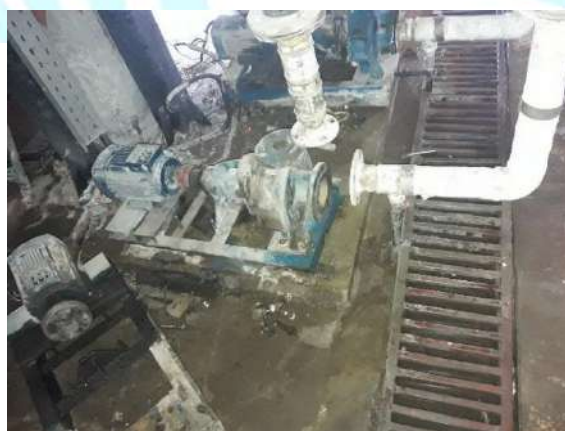
شکل ۱۲-۵۸- آسیب به بخش از لوله‌کشی و اتصالات تاسیسات
