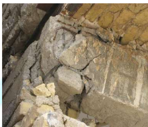
شکل ۷-۱۶- عدم اتصال مناسب کلاف افقی در کنج
