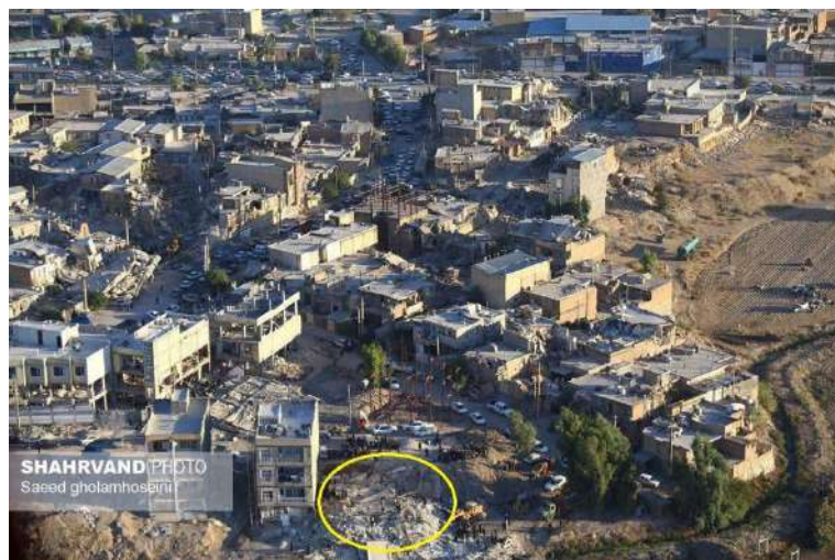
شکل ۹-۲- تصویر هوایی این دو ساختمان بعد از زلزله با دایره مشخص شده است
