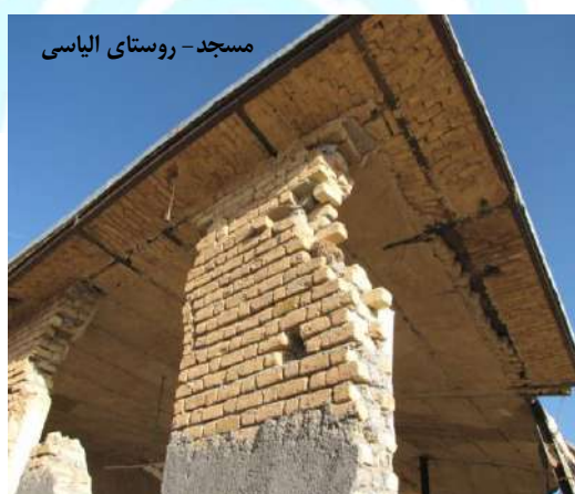
شکل ۷-۱۱- عملکرد قابل قبول سقف‌های طاق ضربی با رعایت حداقل ضوابط استاندارد ۲۸۰۰
