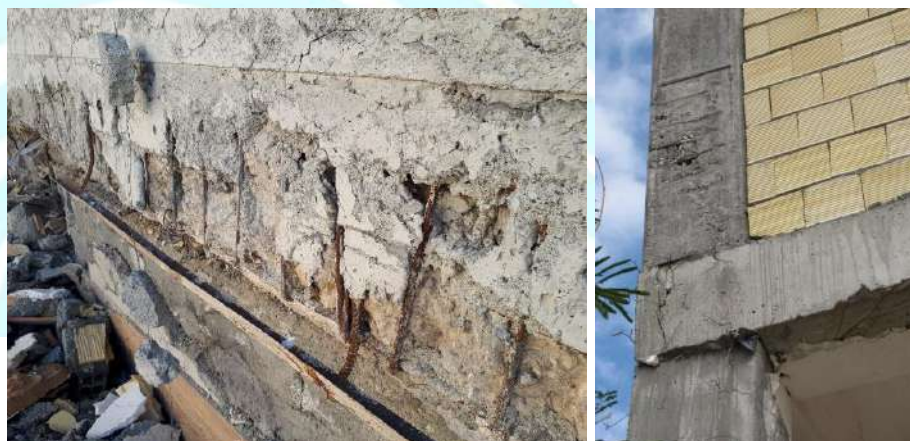
شکل ۵-۱۱- ضخامت کم و متخلخل پوشش بتن (ضعف پایایی)
