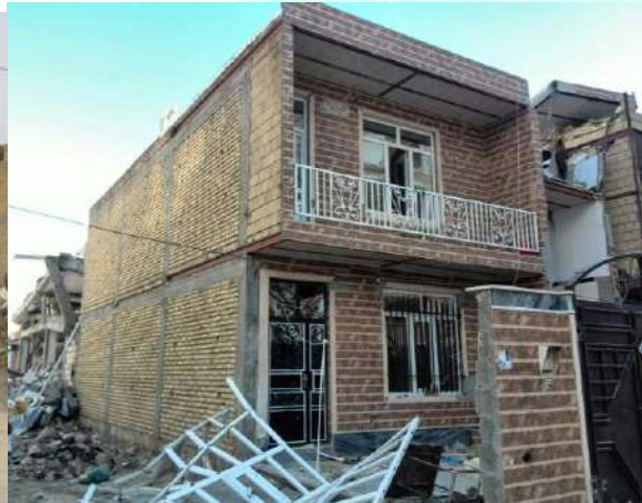
شکل ۷-۸- عملکرد ساختمان‌های مصالح بنایی با رعایت حداقل ضوابط در سرپل‌نهاب
