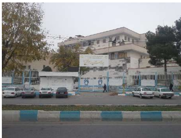
شکل ۱۲-۲۷- نمای شمال غرب از دو ساختمان اصلی بیمارستان امام‌خمينی اسلام‌آبادغرب
