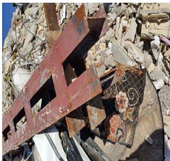
(الف) ساختمان تخریب شده
