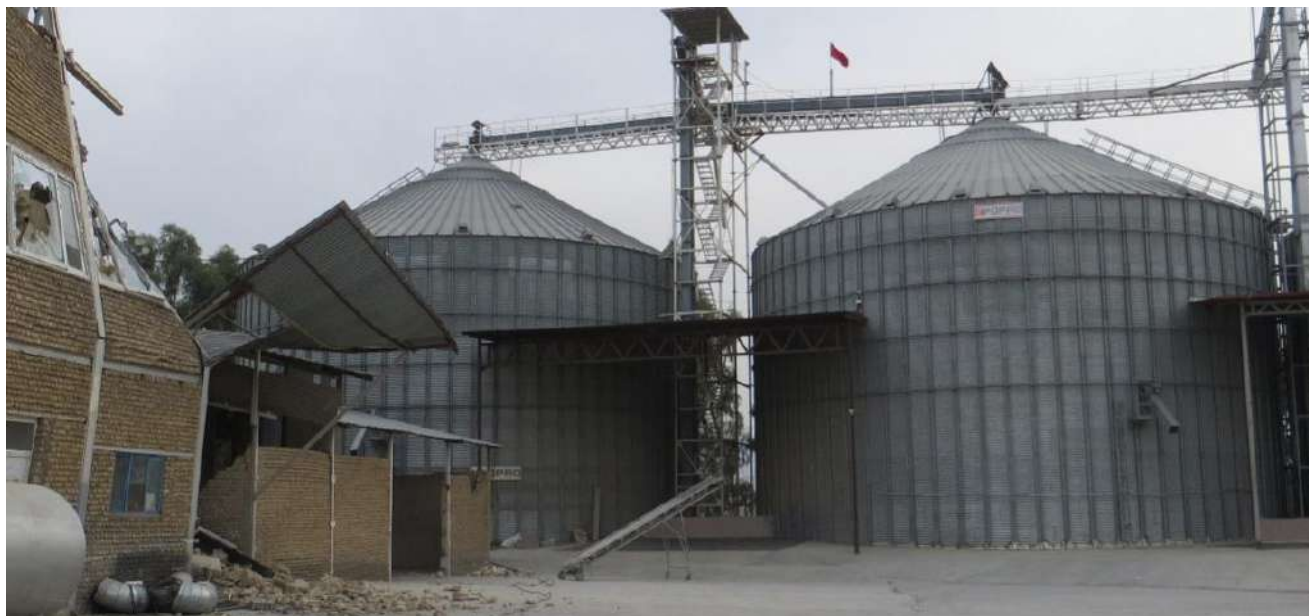
شکل ۱۱-۳- دودعد از سیلوهای گندم کارخانه آرد قصر شیرین در شهرک صنعتی سرپل ذهاب
