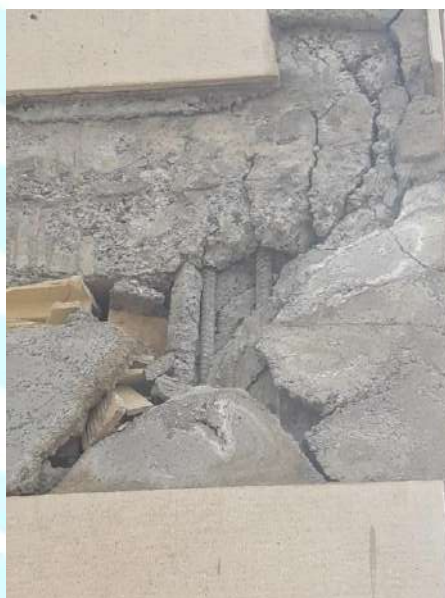
شکل ۱۲-۵۳- آسیب در محل اتصال تیر به ستون در ساختمان اتاقک هواساز بیمارستان
