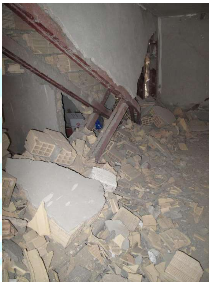
شکل ۸-۲۳- نمایش سیستم لرزه بر استفاده شده. در هر دو جهت مهاربند.
