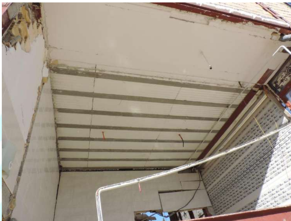
شکل ۸-۹- نوع پوشش سقف و راستای تیر ریزی
