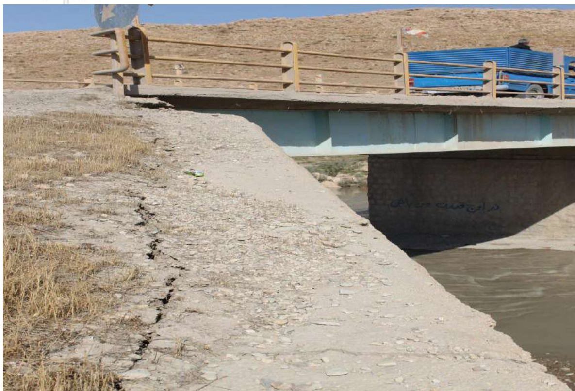
شکل ۱۰-۵- حرکت بخش بالایی کوله پل فلزی دارای دو دهانه
