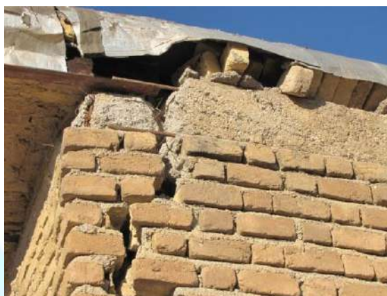
شکل ۷-۱۶- عدم اتصال مناسب کلاف افقی در کنج
