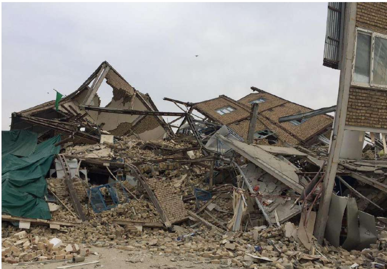
شکل ۱۱-۸- تخریب سالن آسیاب و بسته‌بندی کارخانه آرد شهرک صنعتی سرپل ذهاب
