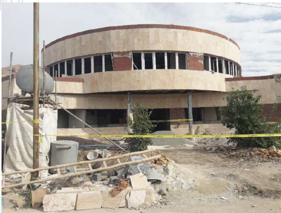
شکل ۱۲-۲۱- نمای ورودی کلینیک
