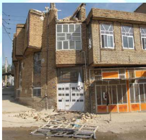
شکل ۷-۷- تخریب کلی یا موضعی خرپشته
