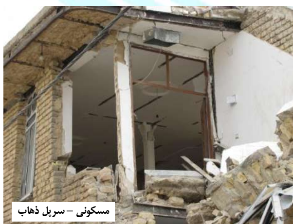
شکل ۷-۱۱- عملکرد قابل قبول سقف‌های طاق ضربی با رعایت حداقل ضوابط استاندارد ۲۸۰۰
