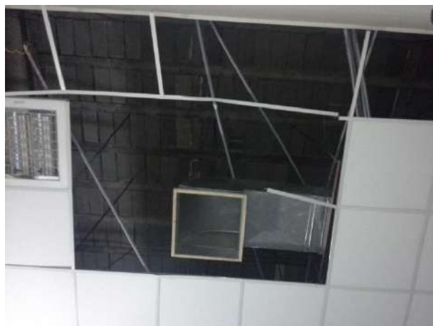
شکل ۱۲-۴۶- سقوط سقف‌های کاغذ مانند اغلب مراکز درمانی دیگر
