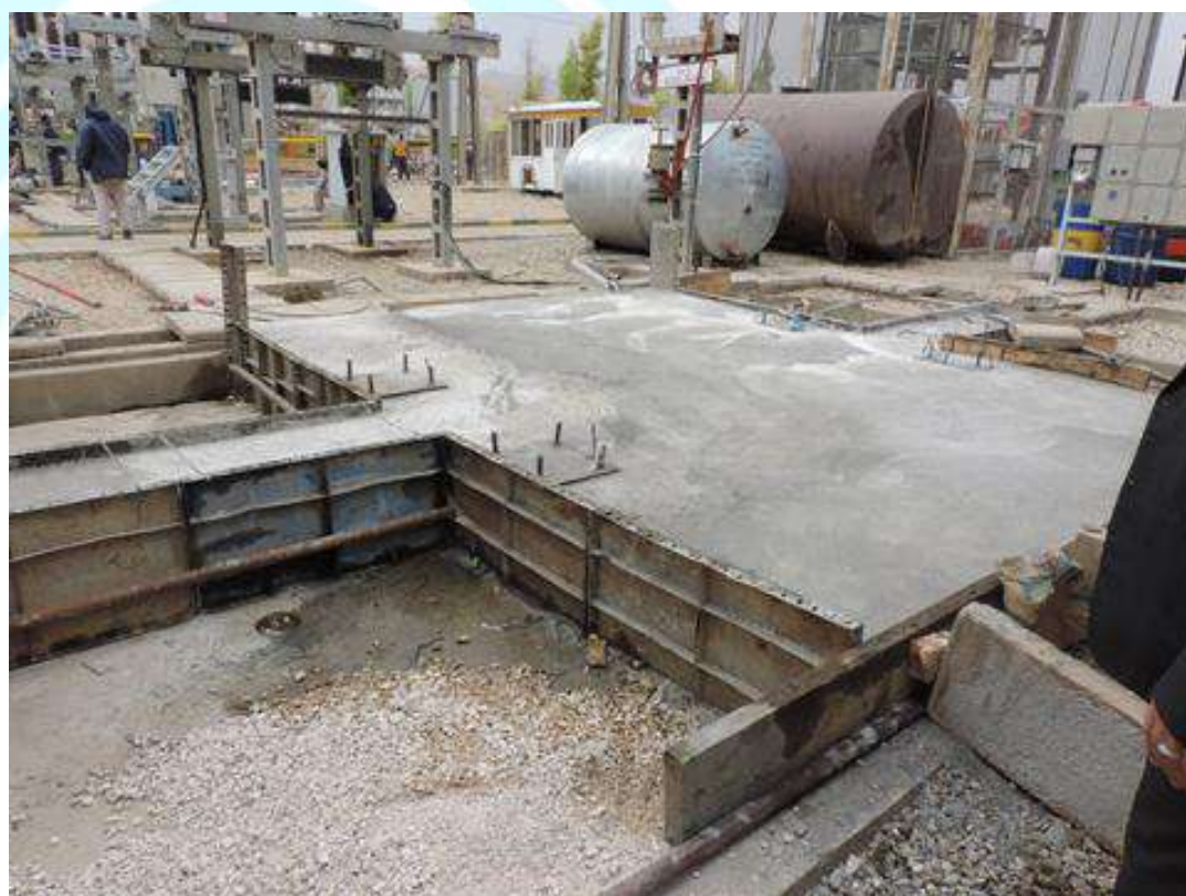
شکل ۱۰-۲۶- احداث فونداسیون برای تثبیت ترانس که از روی ریل در پست ۶۳kV سرپل ذهاب افتاد.
