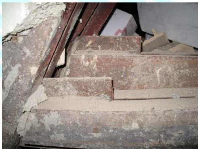
شکل ۸-۲۸- خمش ورق اتصال میانی مهاربندها
