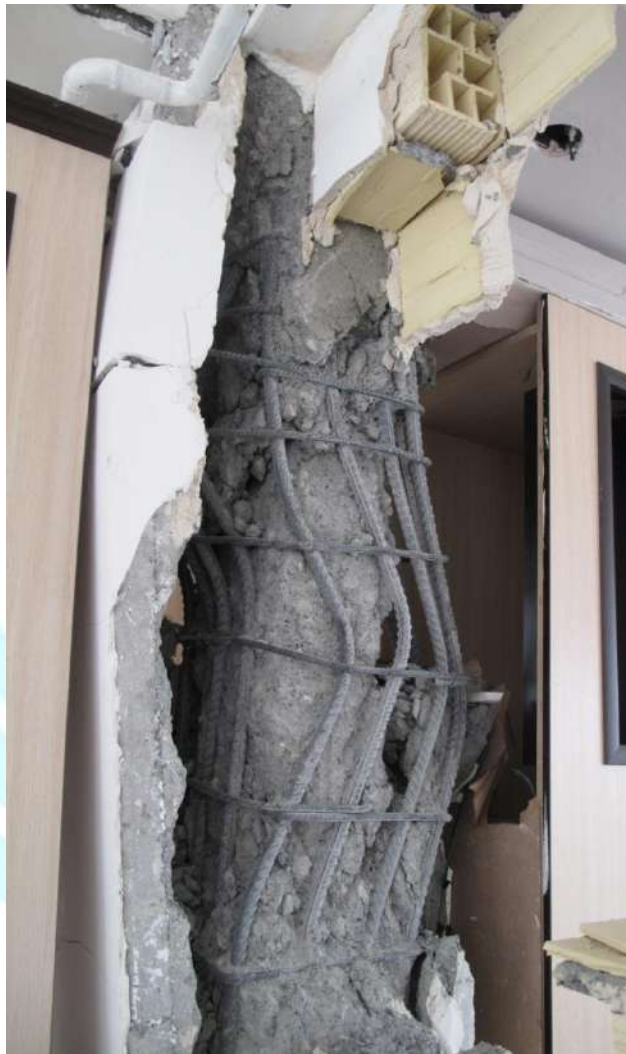
شکل ۵-۱۴- عدم استفاده از خاموت یا تنگ بسته (قلاب انتهایی ۹۰ درجه به‌عنوان تنگ بسته محسوب نمی‌شود)
