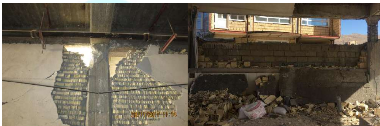
شکل ۵-۵- ایجاد ستون کوتاه به علت ایجاد دستک فشاری ناشی میانقاب
