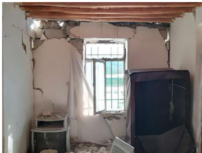
شکل ۷-۴- تخریب دیوارهای سازه‌ای موازی تیر ریزی سقف خارج از صفحه
