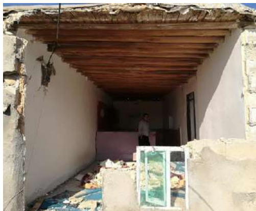
شکل ۷-۴- تخریب دیوارهای سازه‌ای موازی تیر ریزی سقف خارج از صفحه
