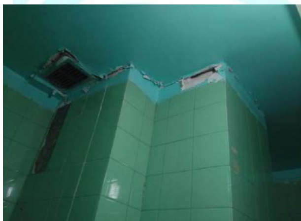
شکل ۱۲-۷۷- ترک‌خوردگی در دیوارها
