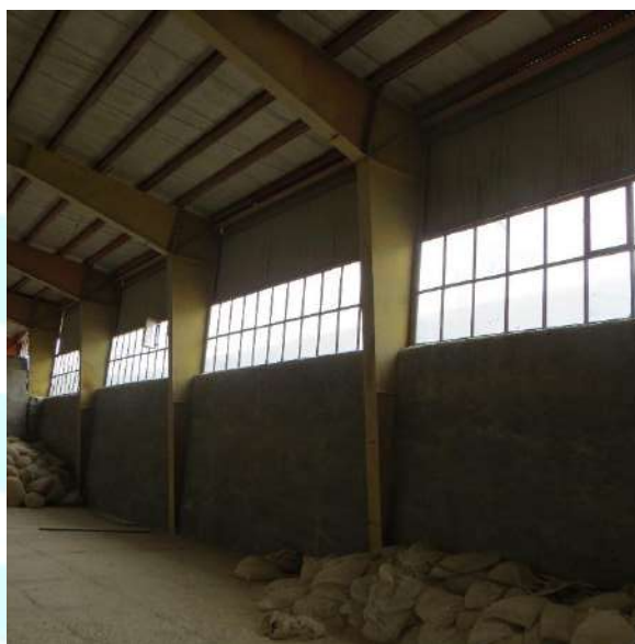
شکل ۱۱-۱۷- کیفیت مناسب ساخت سوله و عدم آسیب به اجزای سازه‌ای و غیرسازه‌ای سوله اصلی کارخانه دان پارت
