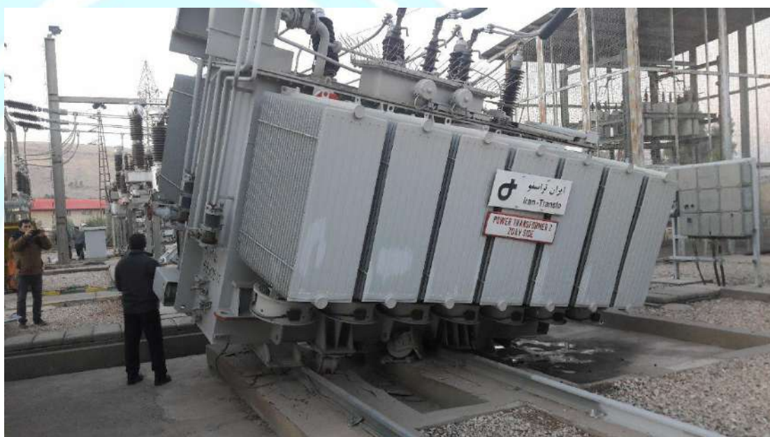
شکل ۱۰-۱۸- افتادن ترانس از روی ریل در پست ۶۳kV سرپل ذهاب (عکس از آموزش و پژوهش علوم صنعت برق)
