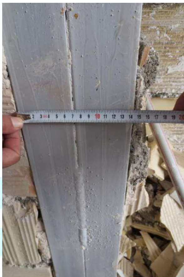
شکل ۸-۲۱- نمایش پروفیل‌های ستونی استفاده شده
