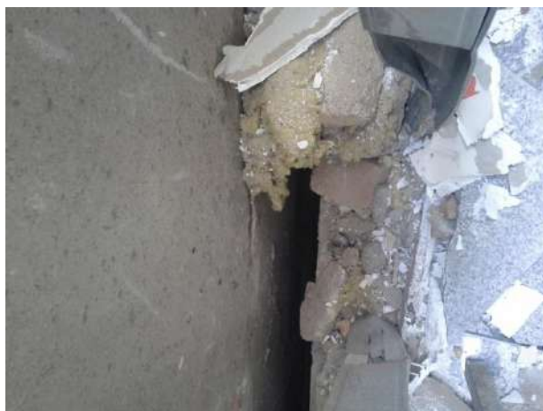
شکل ۱۲-۴۲- درز انقطاع بین دو ساختمان
