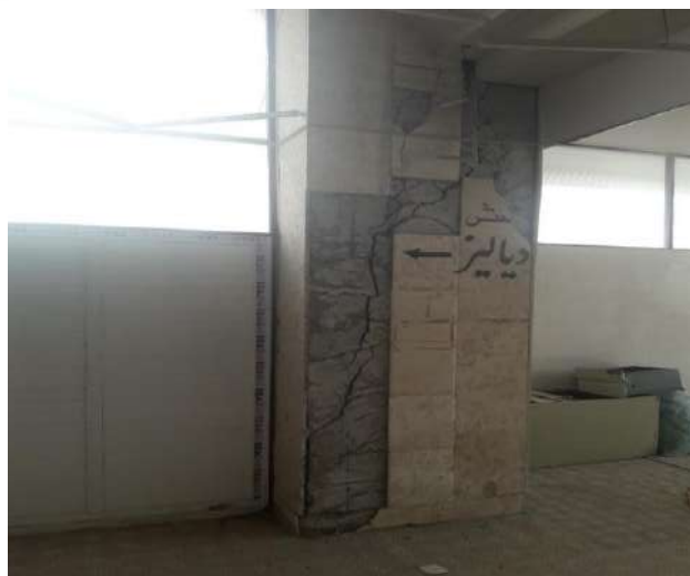
شکل ۱۲-۲۰- تخریب دیوار بخش دیالیز
