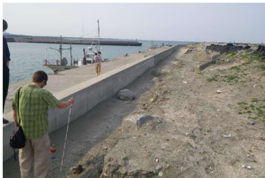
شکل ت-۱۵-۱۳ نمونه‌ای از آب‌شستگی ناشی از سرریز سیال از روی دیوار مانع سونامی و آب‌شستگی هدایت شده
