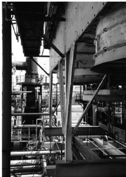
شکل ت-۸-۲۷ فن‌های افقی بر روی تکیه‌گاه‌های بکپارچه
