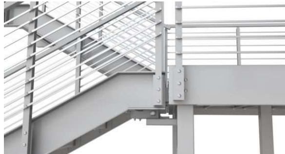
شکل ت-۸-۲۳ اتصال راه‌پله فولادی
