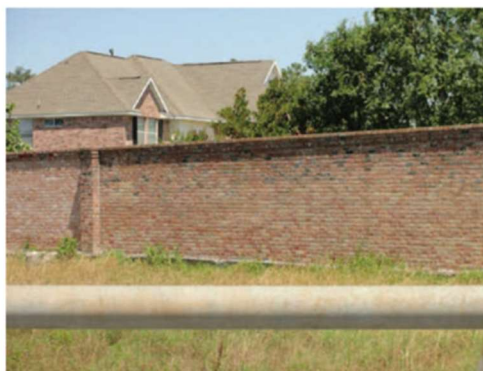
شکل ت-۷-۱۹ دیوار طره‌ای بنایی متداول متکی بر زمین
