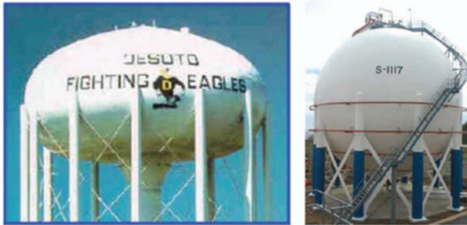
شکل ت-۷-۱۳ مثال‌هایی از برج‌های سازه‌ای که با مخزن متکی یکپارچه‌اند
