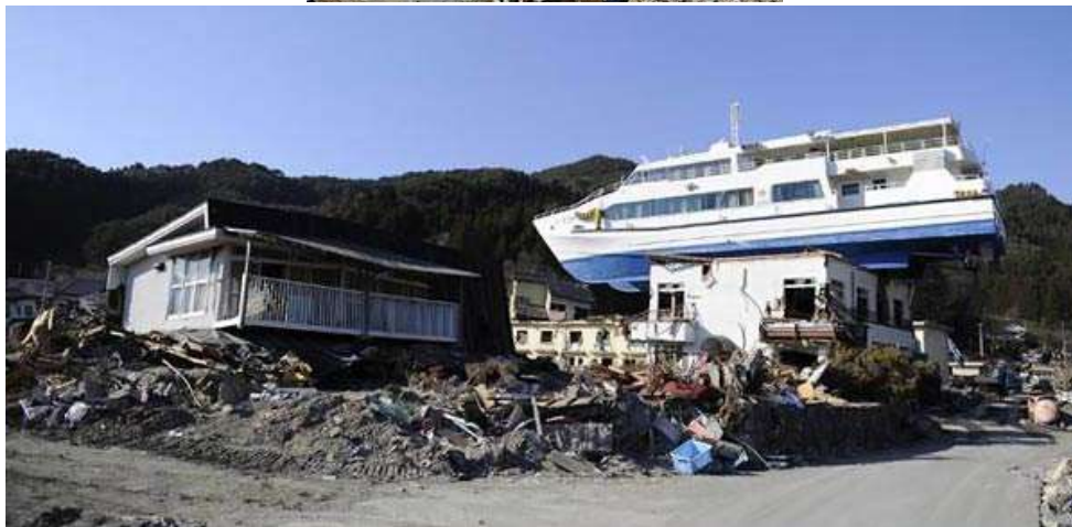
شکل ت-۱۱-۱۵ امکان انتقال اشیای غیرمتعارف در زمانی که ارتفاع موج یا عمق آب‌گرفتگی سونامی بسیار زیاد باشد وجود دارد
