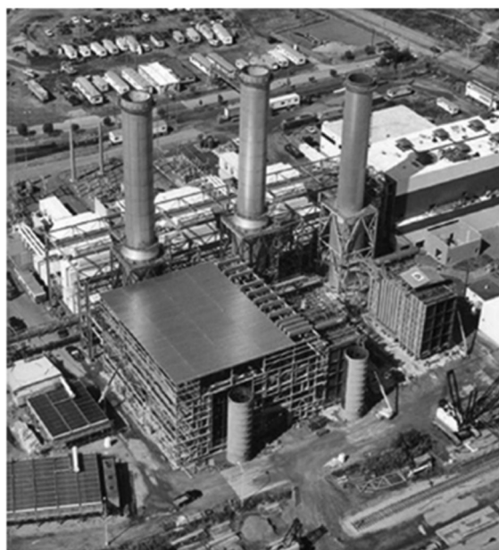
شکل ت-۷-۳ مولدهای بخاری با بازیافت حرارت
