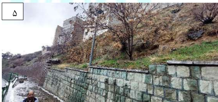
شکل ۶: تصاویر ۱ و ۲ برهم زدن روند زهکشی طبیعی روان آبهای سطحی و ایجاد آبکندهایی در توده لغزشی قدیمی در اثر دیوارهای حفاظتی مسیر پیاده روی که منجر به ریزش واریزه‌ها و قطعات سنگی از روی دیوار بر بستر مسیر شده‌اند (تصاویر ۳ تا ۵)
