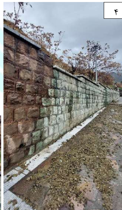
شکل ۶: تصاویر ۱ و ۲ برهم زدن روند زهکشی طبیعی روان آبهای سطحی و ایجاد آبکندهایی در توده لغزشی قدیمی در اثر دیوارهای حفاظتی مسیر پیاده روی که منجر به ریزش واریزه‌ها و قطعات سنگی از روی دیوار بر بستر مسیر شده‌اند (تصاویر ۳ تا ۵)
