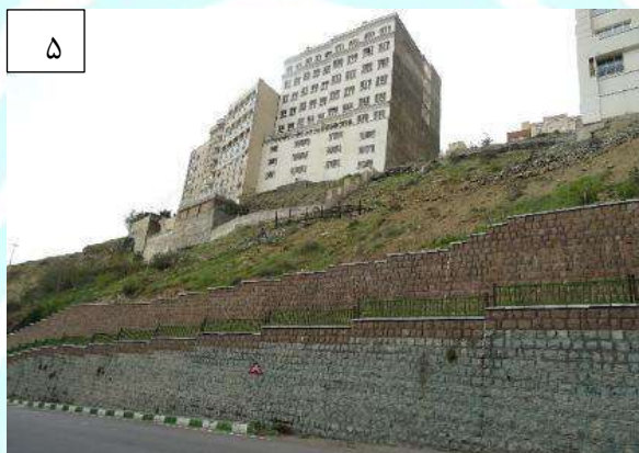
شکل ۴: تصاویر ۱ تا ۳ روند ساخت برج‌های مسکونی در لبه شیب، دامنه زمین لغزشی باغ شاطر (به ترتیب در سال ۲۰۰۰، سال ۲۰۰۴) (ساخت اولین برج و وضعیت کنونی با ۵ برج مسکونی ساخته شده)؛ ۴ تا ۶ تصاویر زمینی از ساخت و سازهای انجام شده و موقعیت آنها نسبت به زمین
